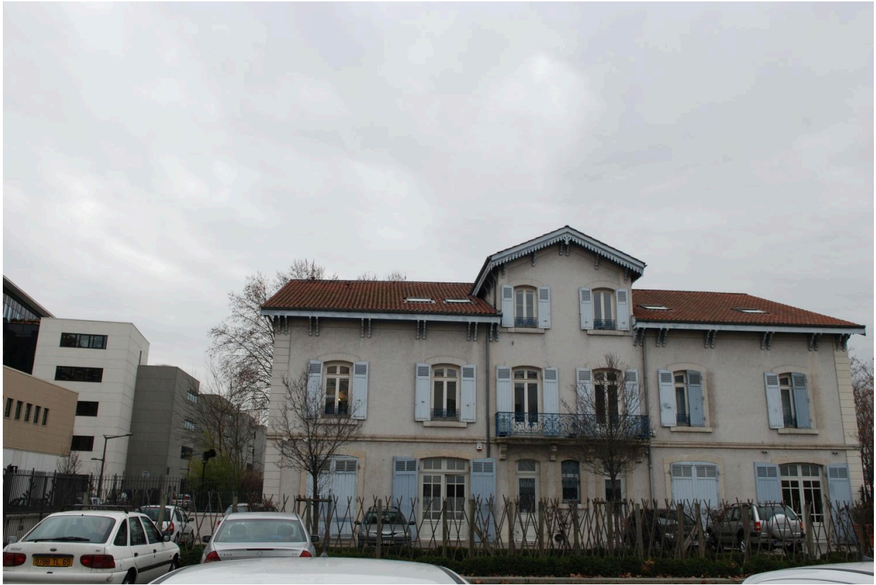
Détail façade sud
