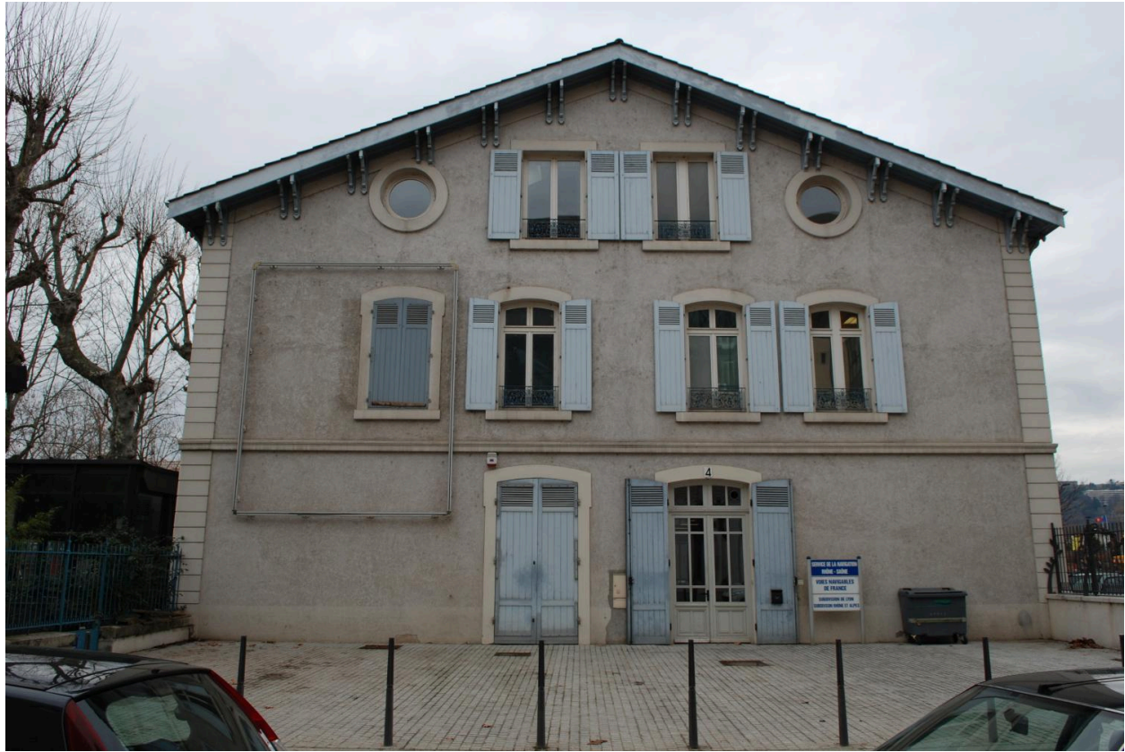
Façade sud des bureaux
