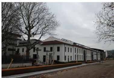
Vue nord-ouest Phot. Nadine Halitim-Dubois IVR82_20106900077NUCA
