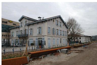
Vue d'ensemble nord-ouest. Phot. Nadine Halitim-Dubois IVR82_20106900086NUCA
