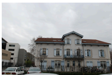
Détail façade sud Phot. Nadine Halitim-Dubois IVR82_20106900088NUCA
