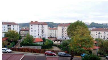
Vue d'ensemble depuis l'ouest Phot. Catherine Guégan IVR82_20086902818NUCA
