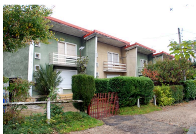
Vue d'ensemble des immeubles en R+1 au nord de la parcelle Phot. Catherine Guégan IVR82_20086902820NUCA
