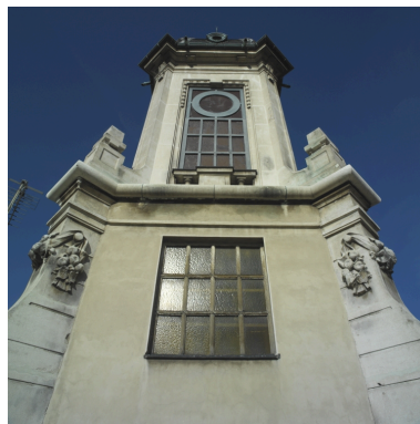
Elévation sud du beffroi Phot. Eric Dessert IVR82_20046902008NUCA
