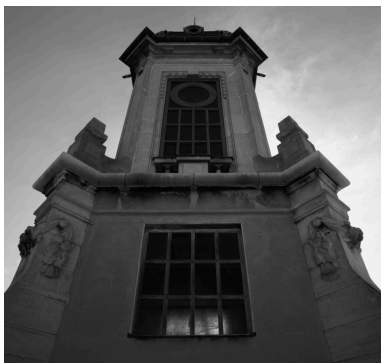
Elévation ouest du beffroi Phot. Eric Dessert IVR82_20046902007NUC
