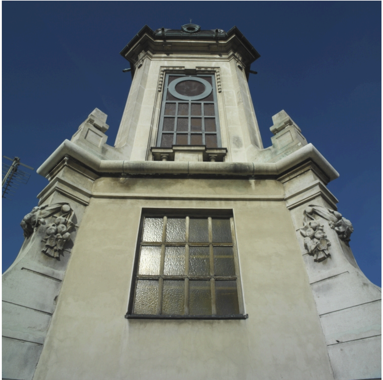
Elévation sud du beffroi
