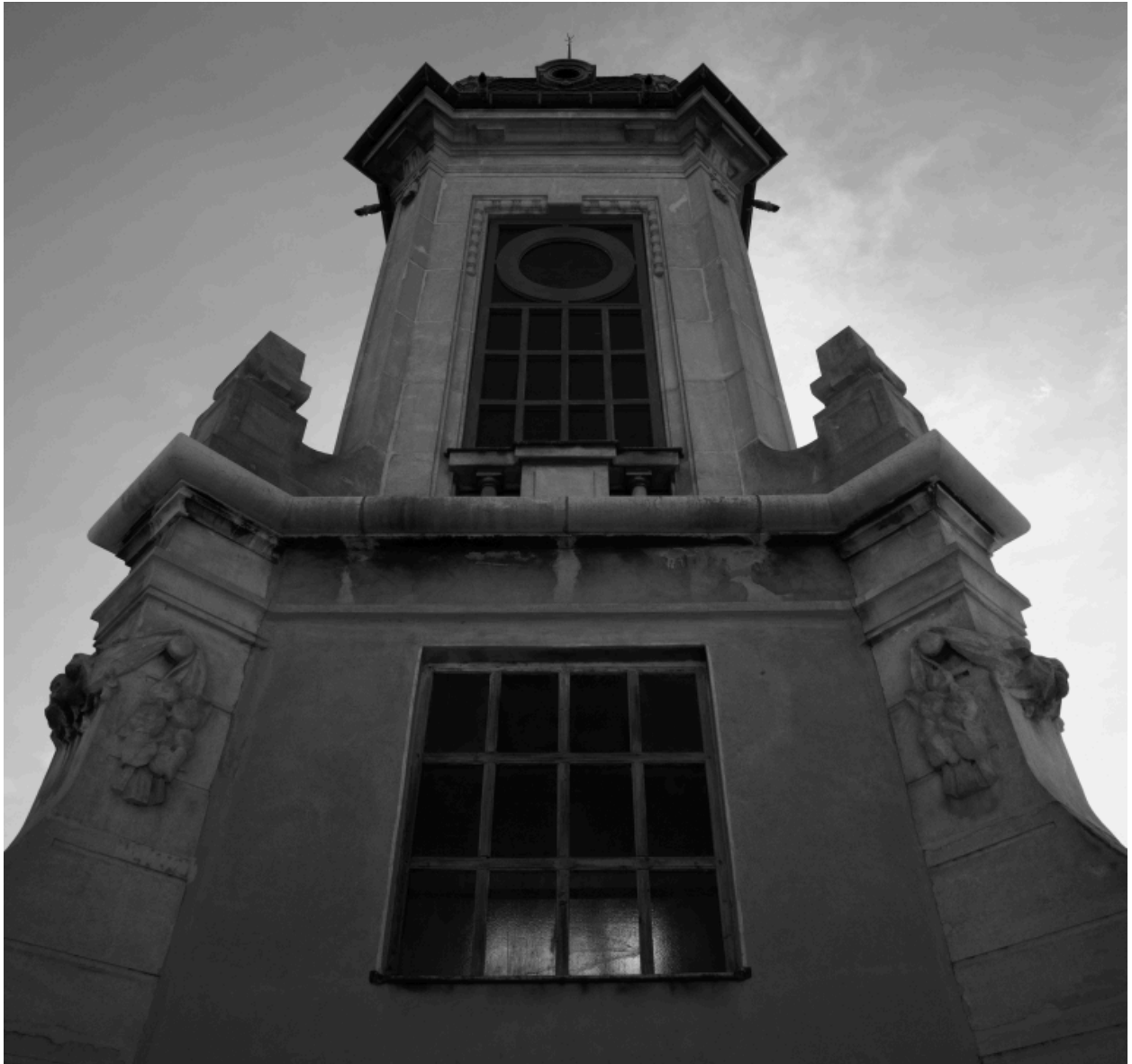
Elévation ouest du beffroi
