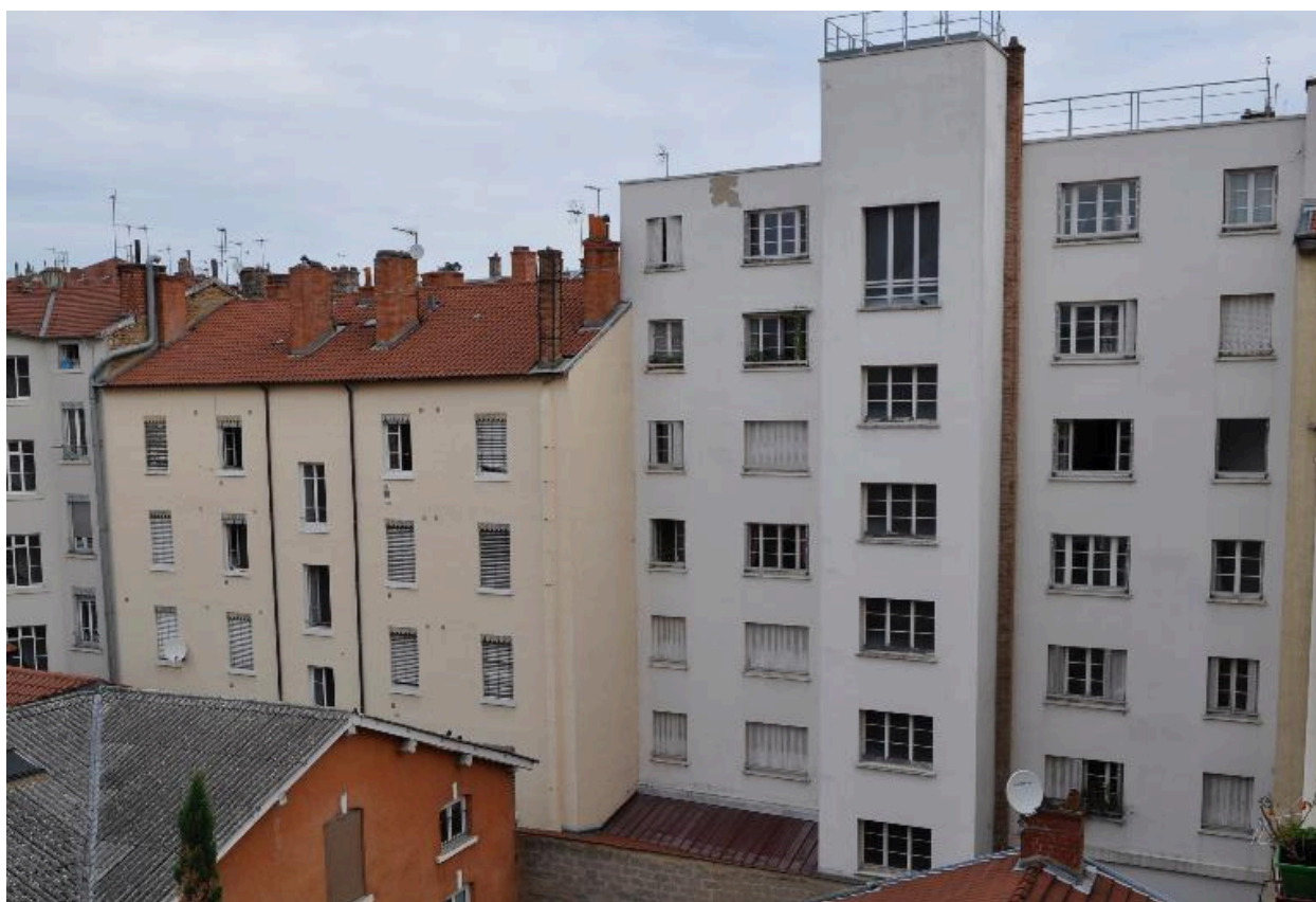
Vue générale de l'élévation sur cour (à gauche)
