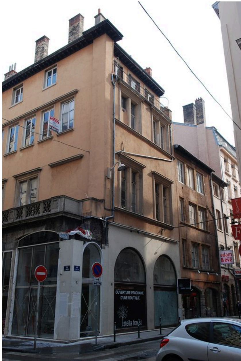
Elévation sud et partie de l'élévation ouest depuis la rue Tupin
