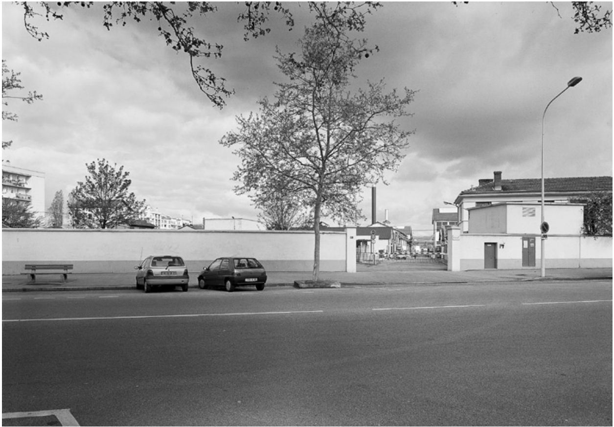
Entrée livraison, vue est
