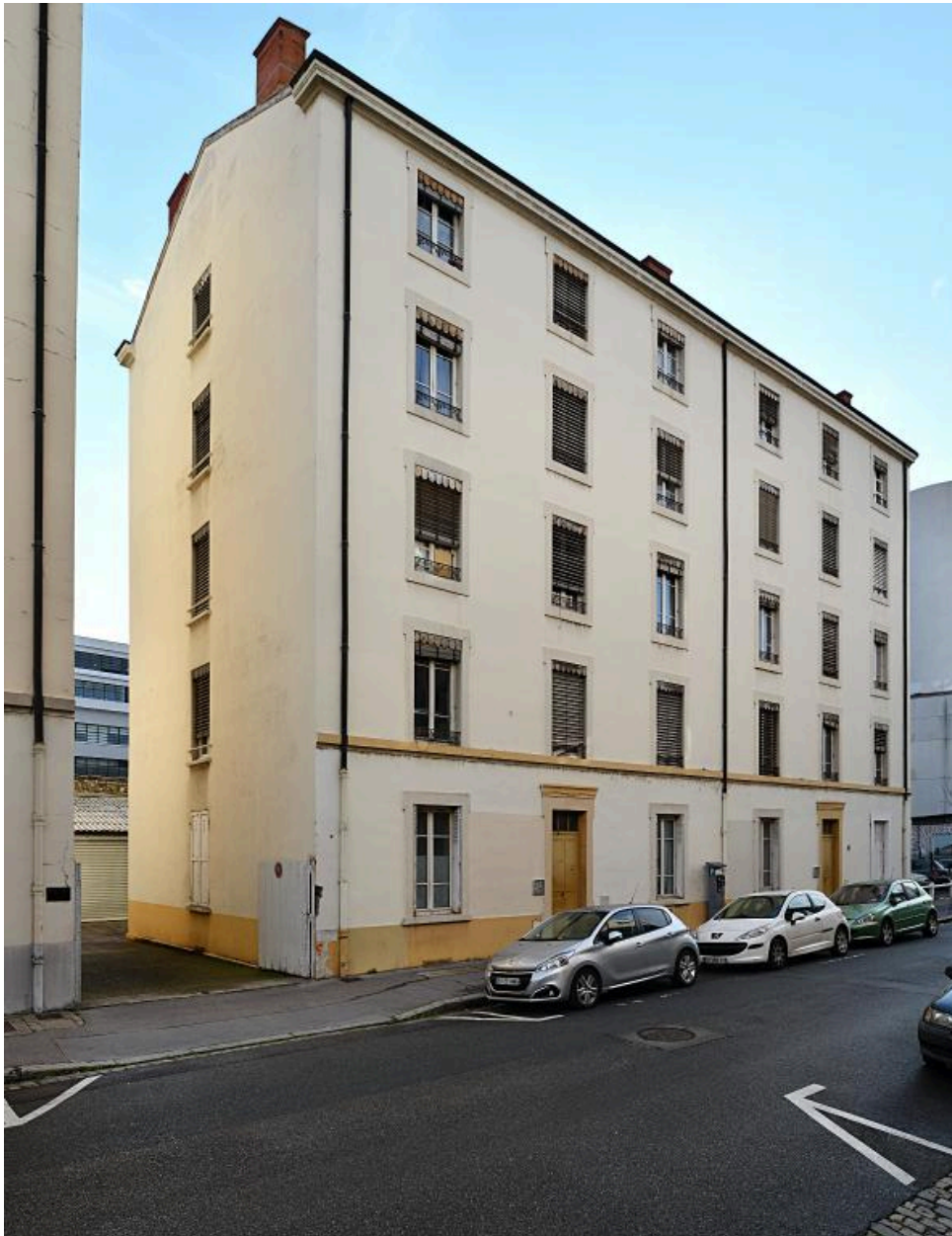
Immeubles jumelés n°55-57 rue Pasteur, élévations sur rue
