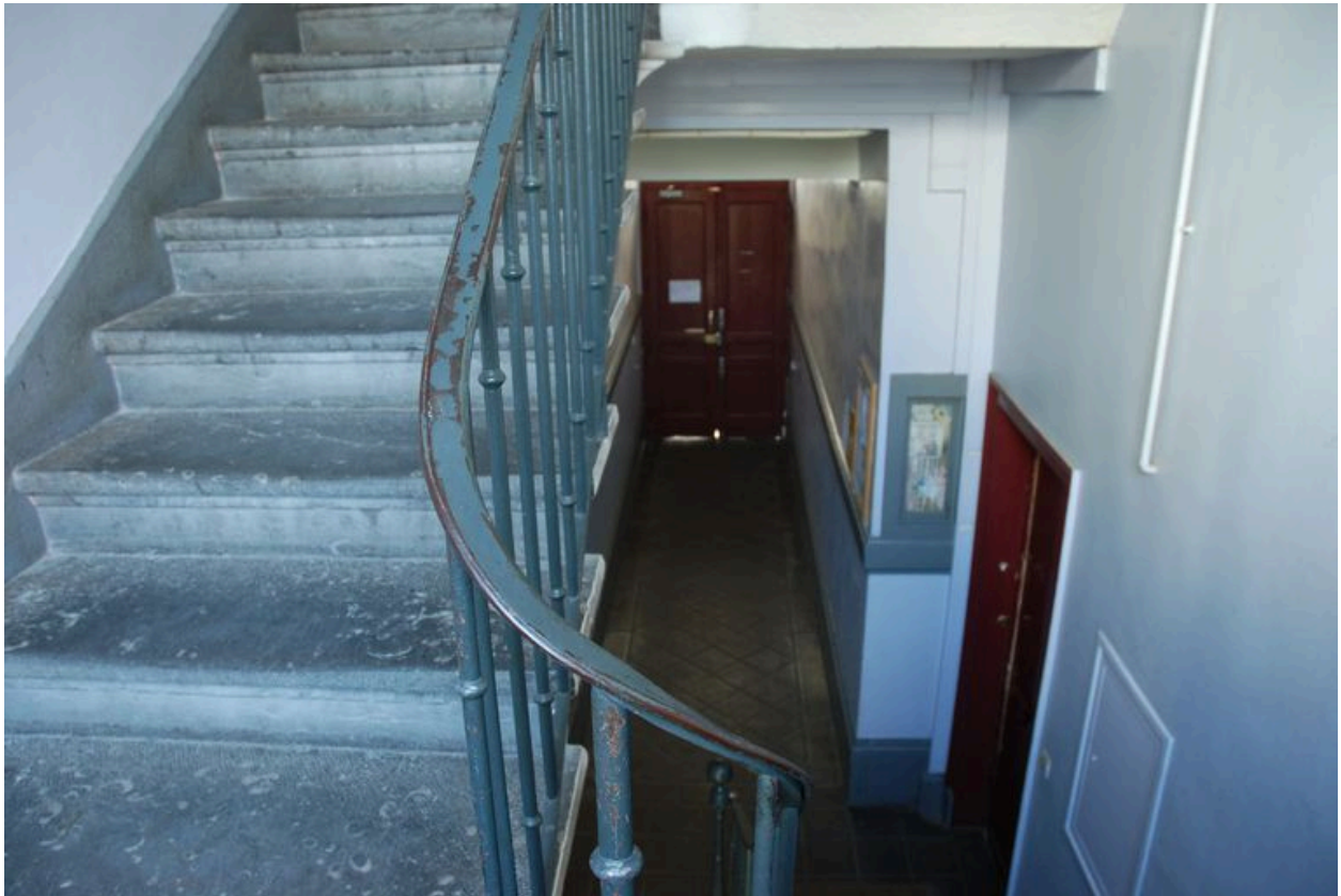
4 rue Salomon-Reinach : vue de l'entrée et de l'escalier
