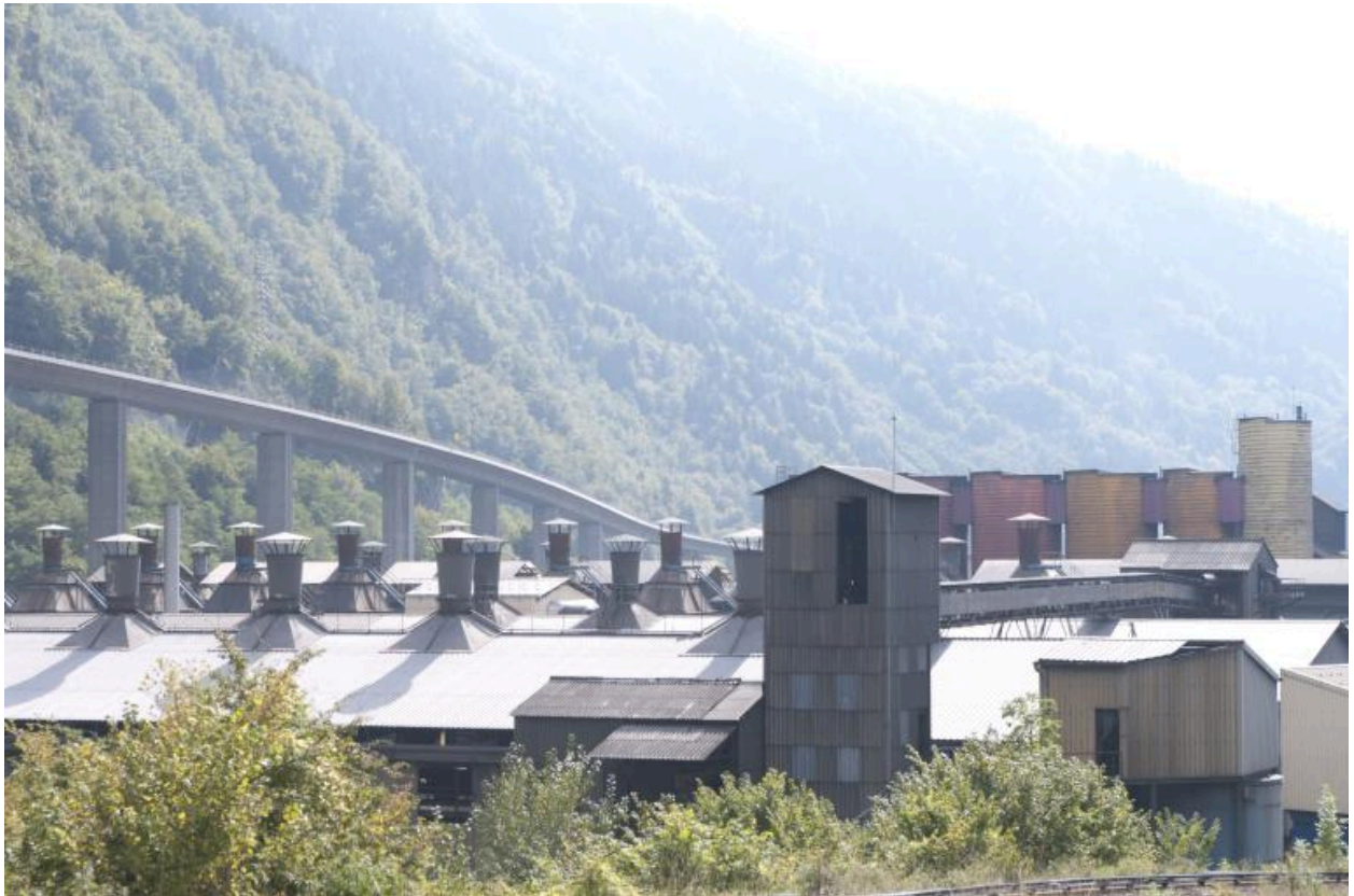
Vue générale des ateliers de l'usine SLG CARBON au pied du viaduc des Egratz © Département Haute-Savoie - Cliché J. Laidebeur
