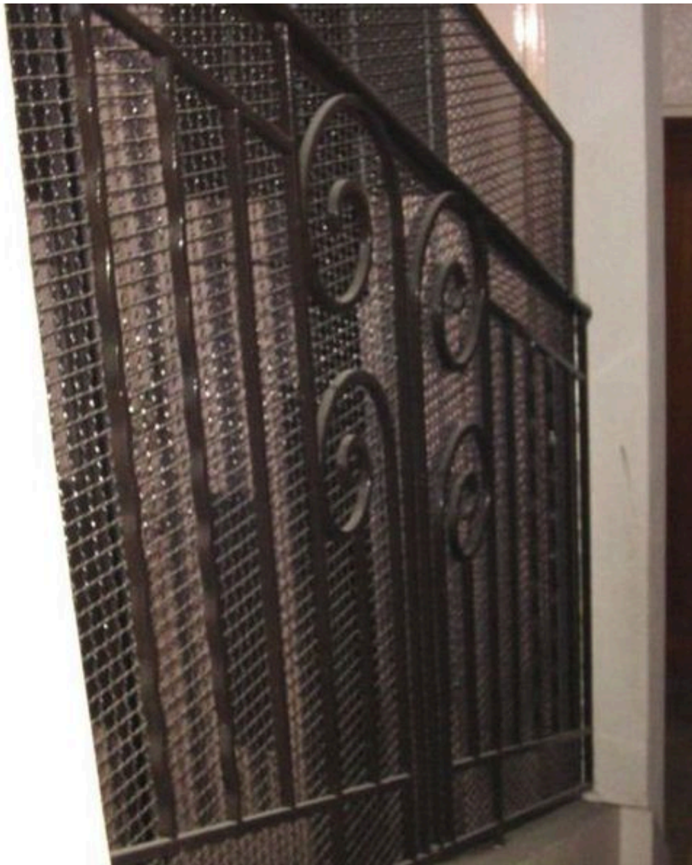
Ferronnerie de la cage d'escalier
