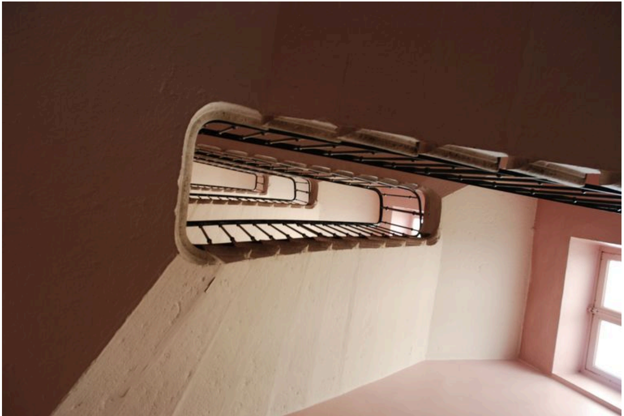
55-57 rue Pasteur : vue de l'escalier
