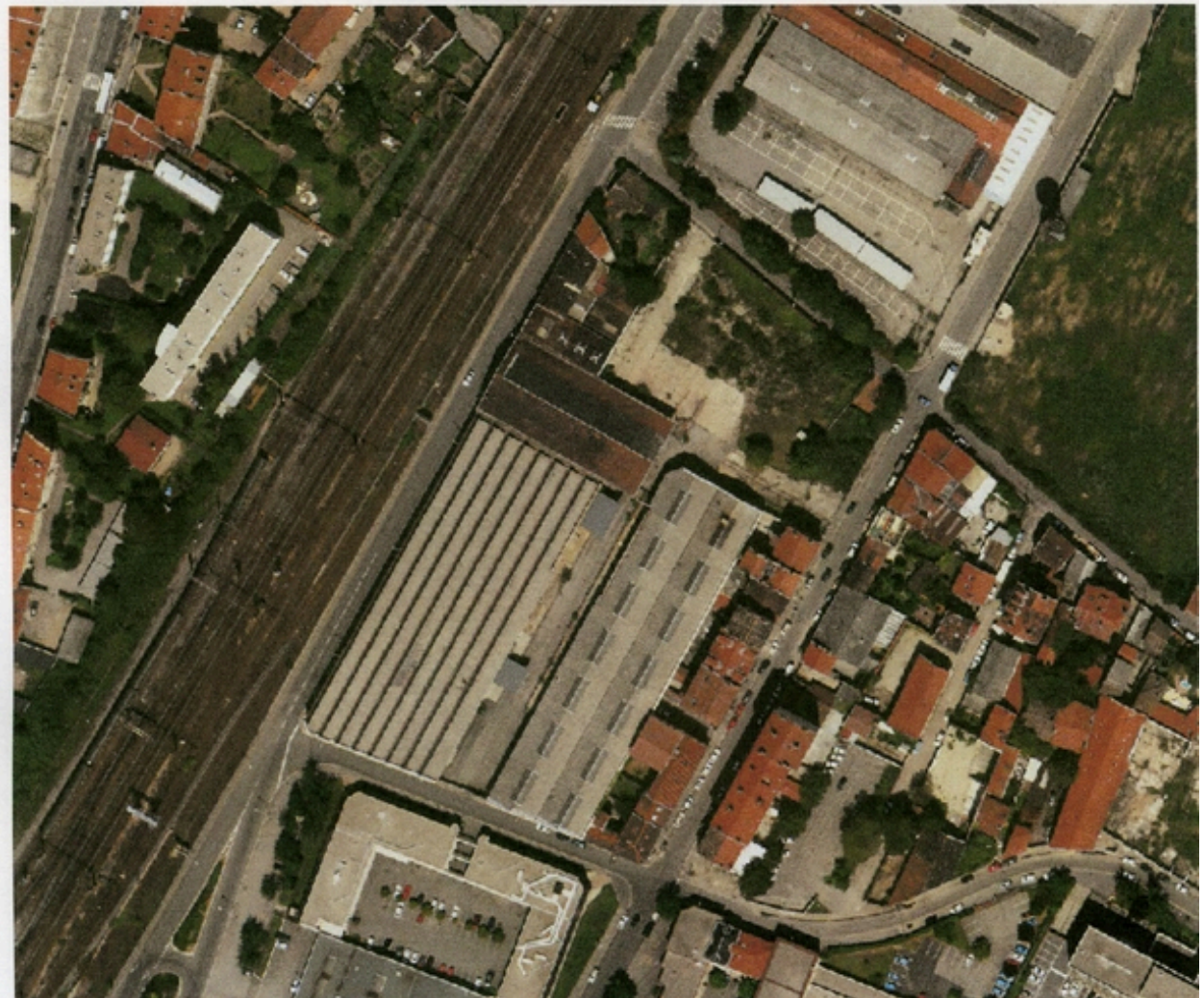
Vue zénithale des anciennes messageries lyonnaises (1997)
