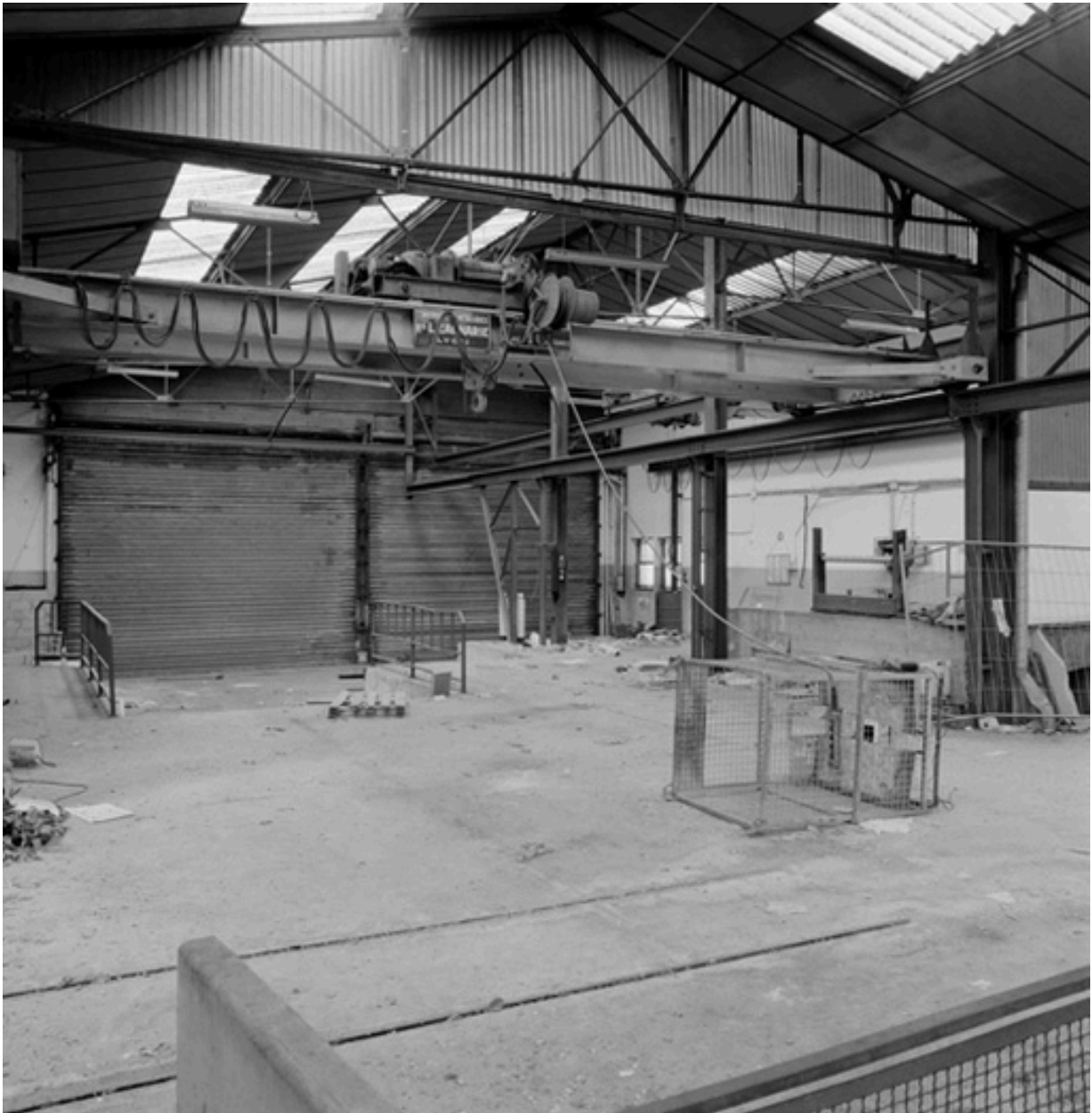
Extension construit en 1960
