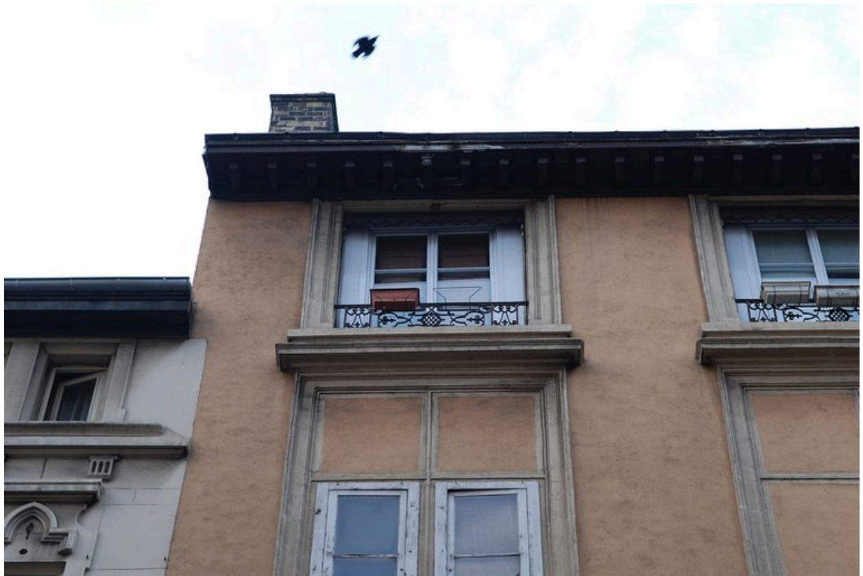
Elévation nord : 3eme étage, garde-corps
