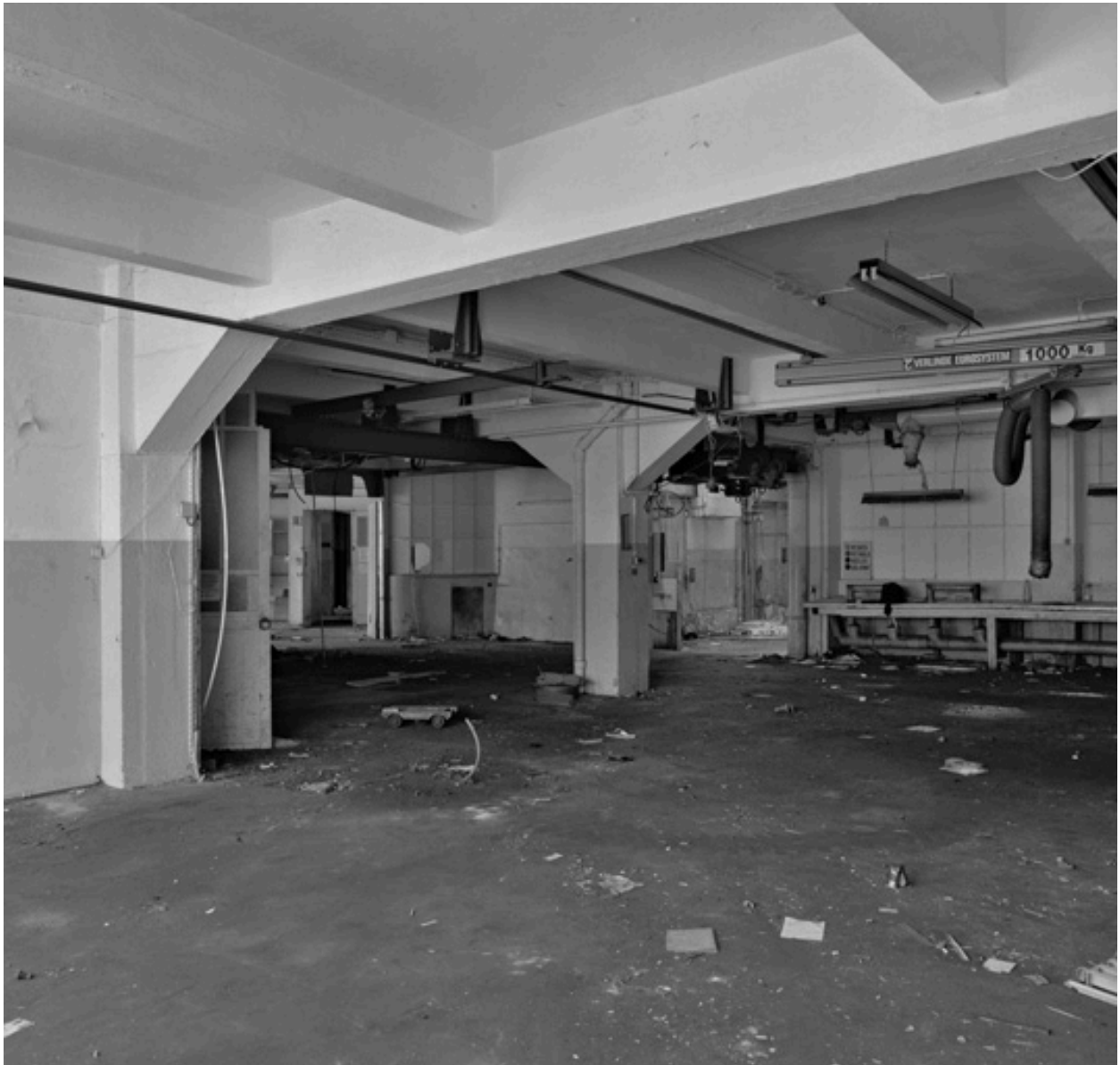
Vue d'ensemble atelier du second étage
