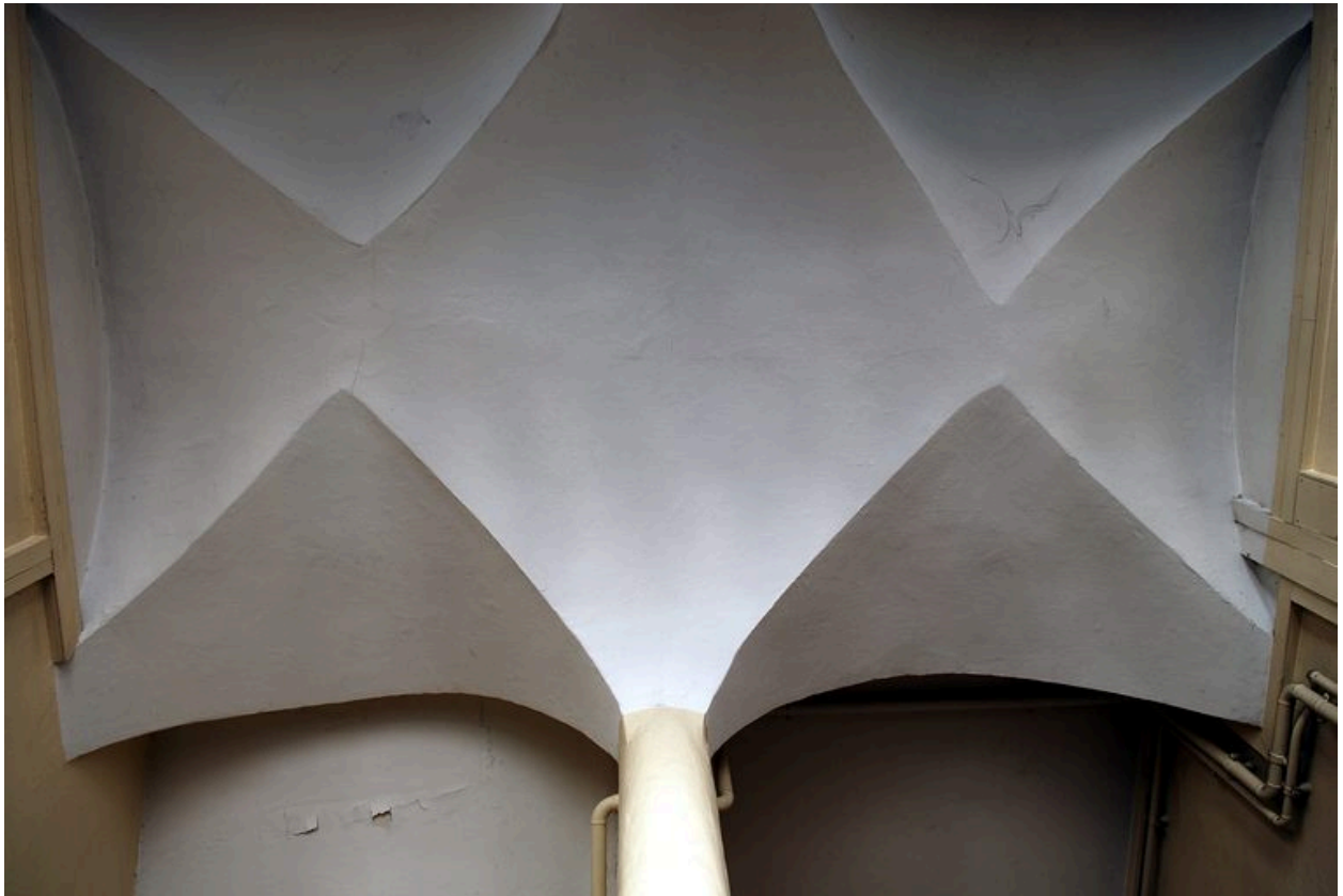
Cage d'escalier : voûte de palier
