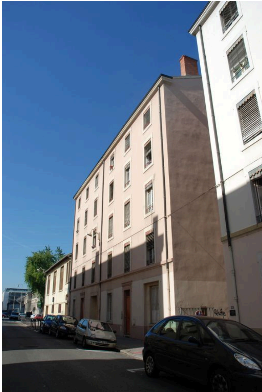
Immeubles jumelés n°62-64 rue Pasteur, élévations sur rue
