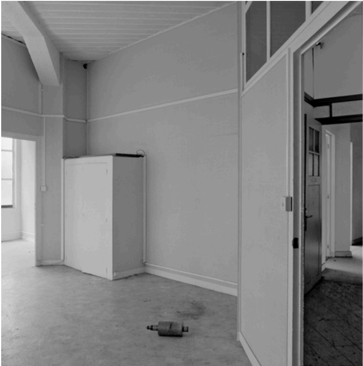
Bureaux du premier étage
