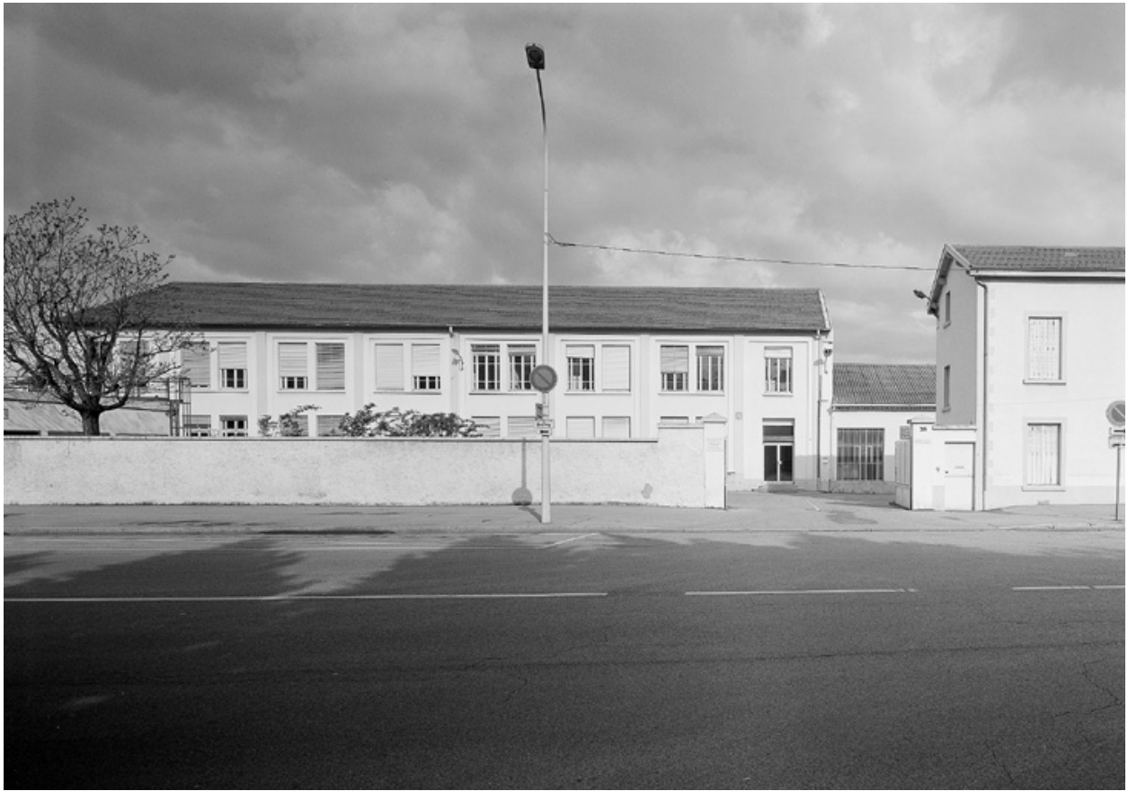
Vue générale, entrée principale vue est
