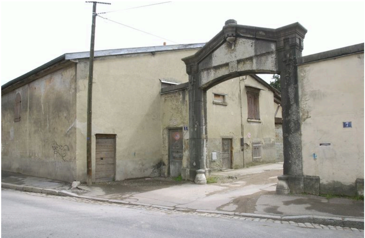
Vue de situation du portail 3 rue des Deux-Amants
