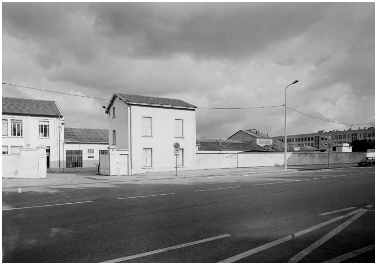
Vue d'ensemble sud-est
