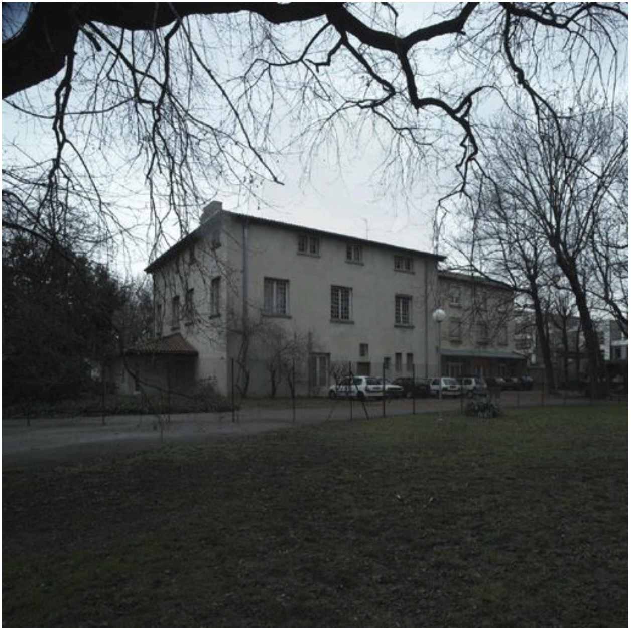
Façade latérale (nord) à gauche et arrière (ouest) à droite
