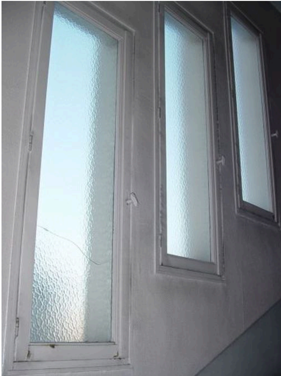
Vue intérieure des baies éclairant la cage d'escalier
