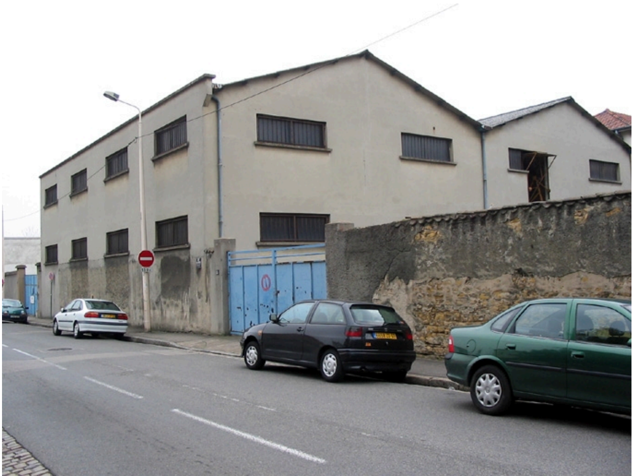
Façade rue Saint-Simon
