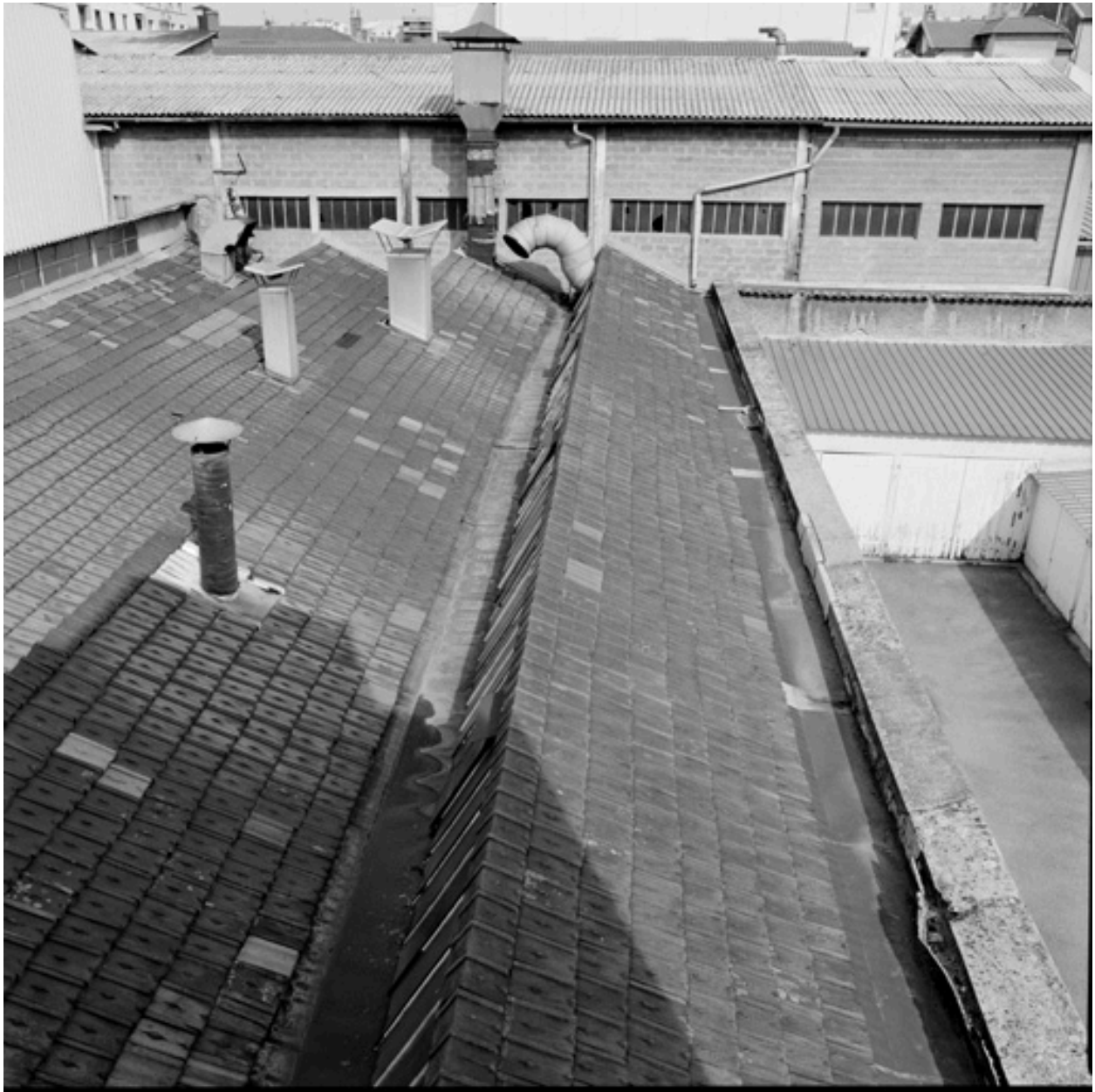
Vue sud-est des toits sheds
