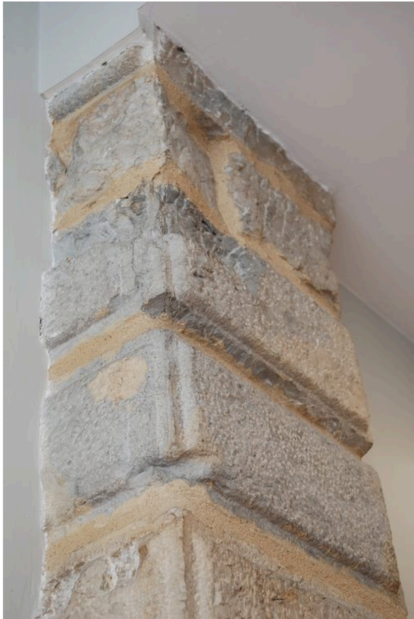
Intérieur ouest : pilier du XVIIe, encoche
