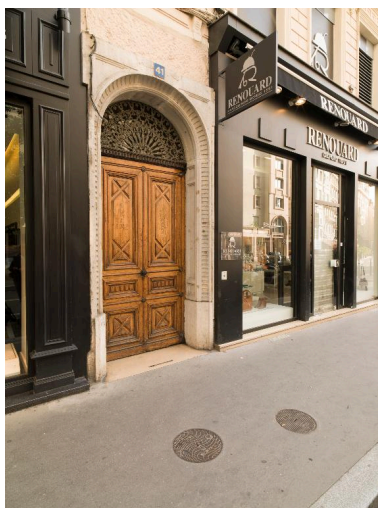
Elévation antérieure : le rez- de-chaussée, vue partielle Phot. Martial Couderette IVR82_20156901763NUCA
