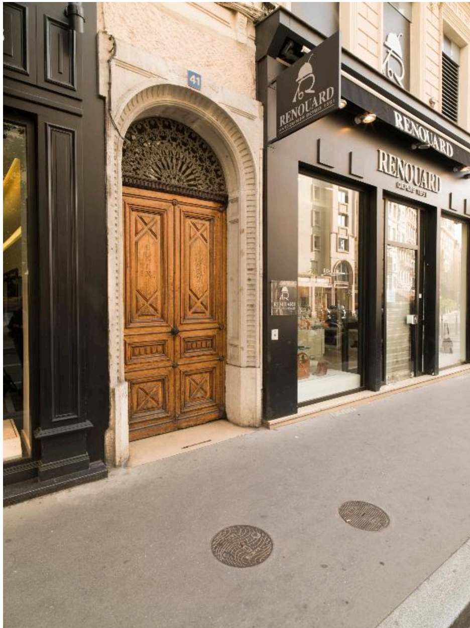
Elévation antérieure : le rez-de-chaussée, vue partielle
