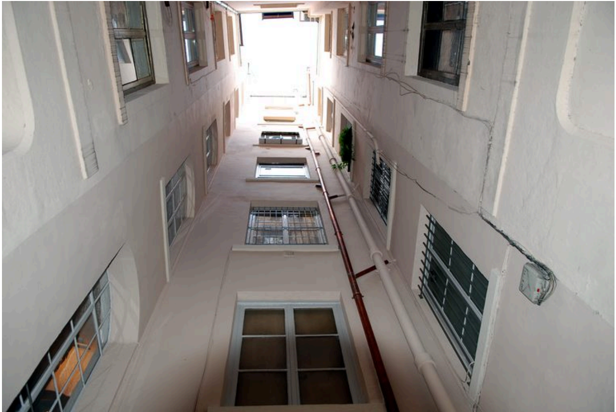
La cour en contre-plongée
