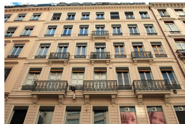
Elévation antérieure : les étages carrés Phot. Véronique Belle IVR82_20096902297NUCA
