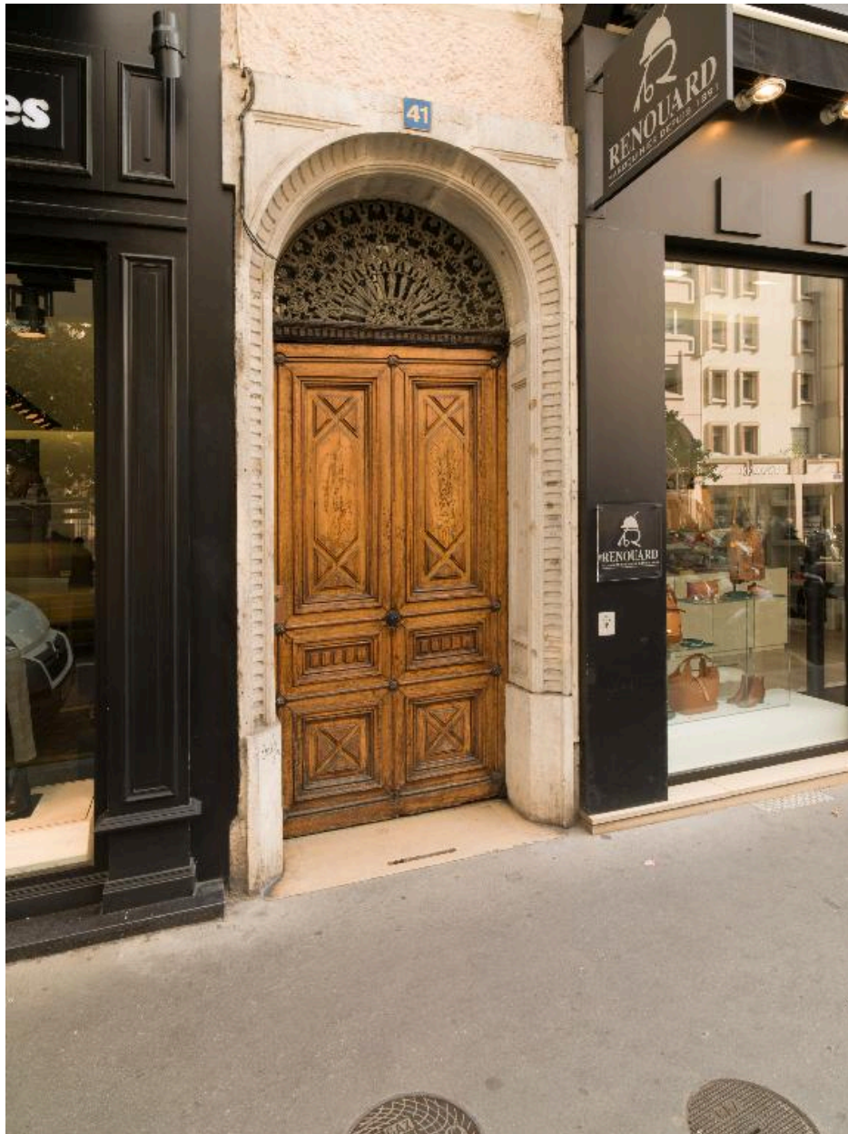
Elévation antérieure : la porte bâtarde
