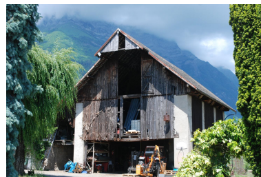
Vue du séchoir 2018 ZS 83, depuis le sud. Phot. Caroline Guibaud IVR84_20247300507NUCA
