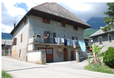
Vue de la maison Donsel (2018 ZS 84, 80), angle sud. Phot. Caroline Guibaud IVR84_20247300509NUCA
