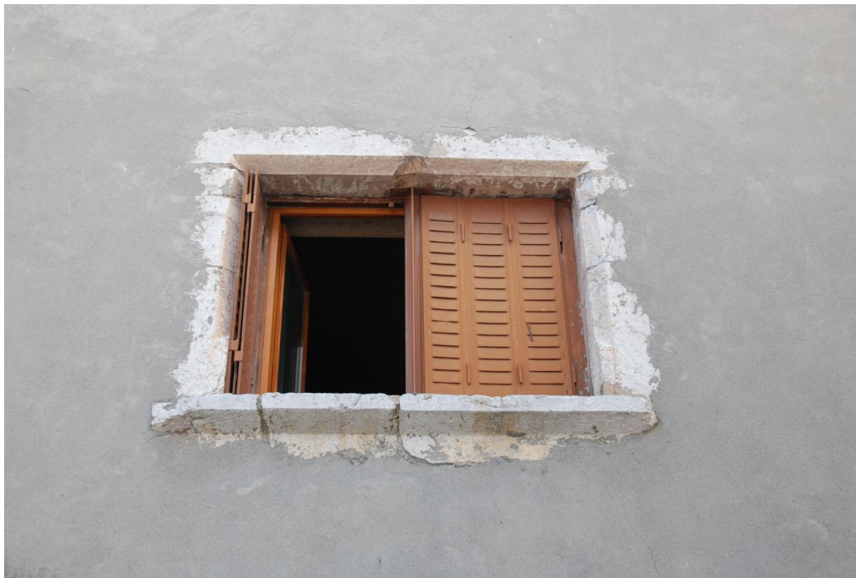
Vue de la maison Donsel (2018 ZS 84, 80), détail de fenêtre à meneau (disparu) sur l'élévation nord-est.
