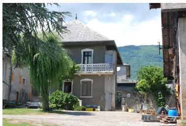
Vue de la maison 2018 ZS 83, depuis le sud. Phot. Caroline Guibaud IVR84_20247300506NUCA
