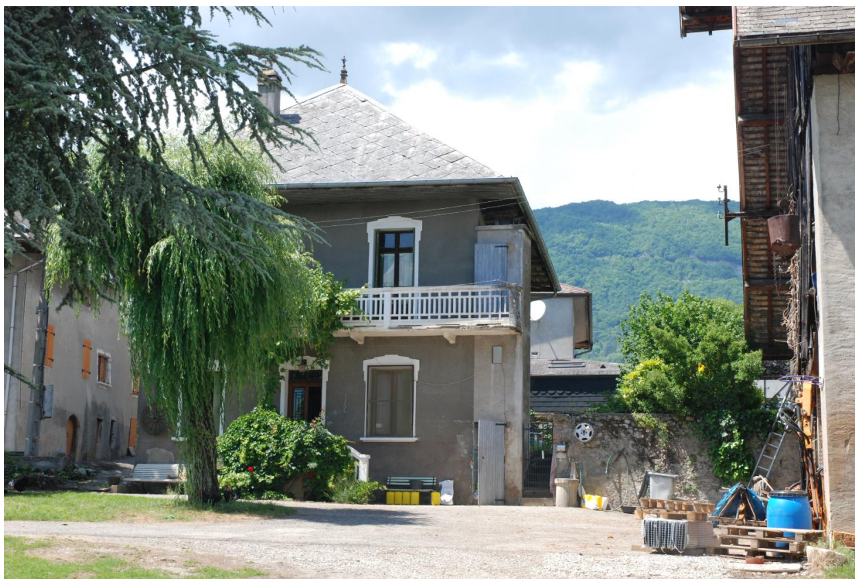
Vue de la maison 2018 ZS 83, depuis le sud.
