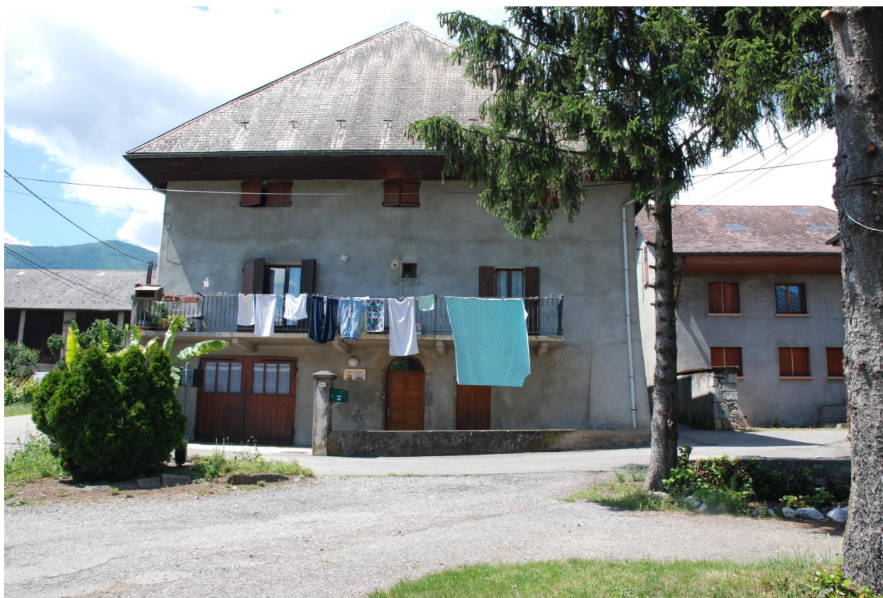
Vue de la maison Donsel (2018 ZS 84, 80), façade sud (sud-ouest).
