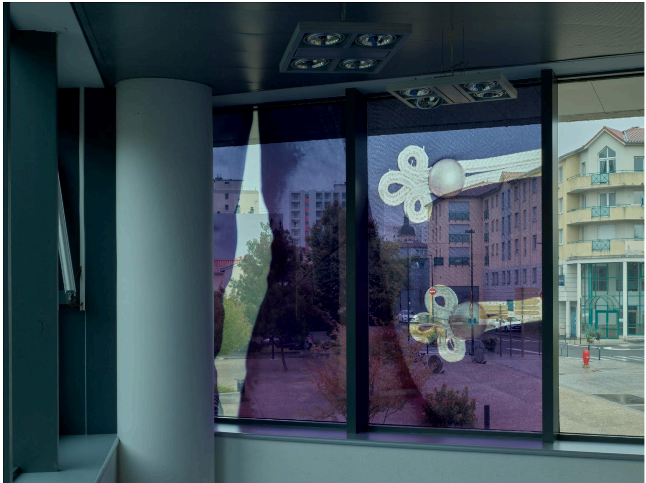
Hall d'entrée : panneau supérieur n° 7.
