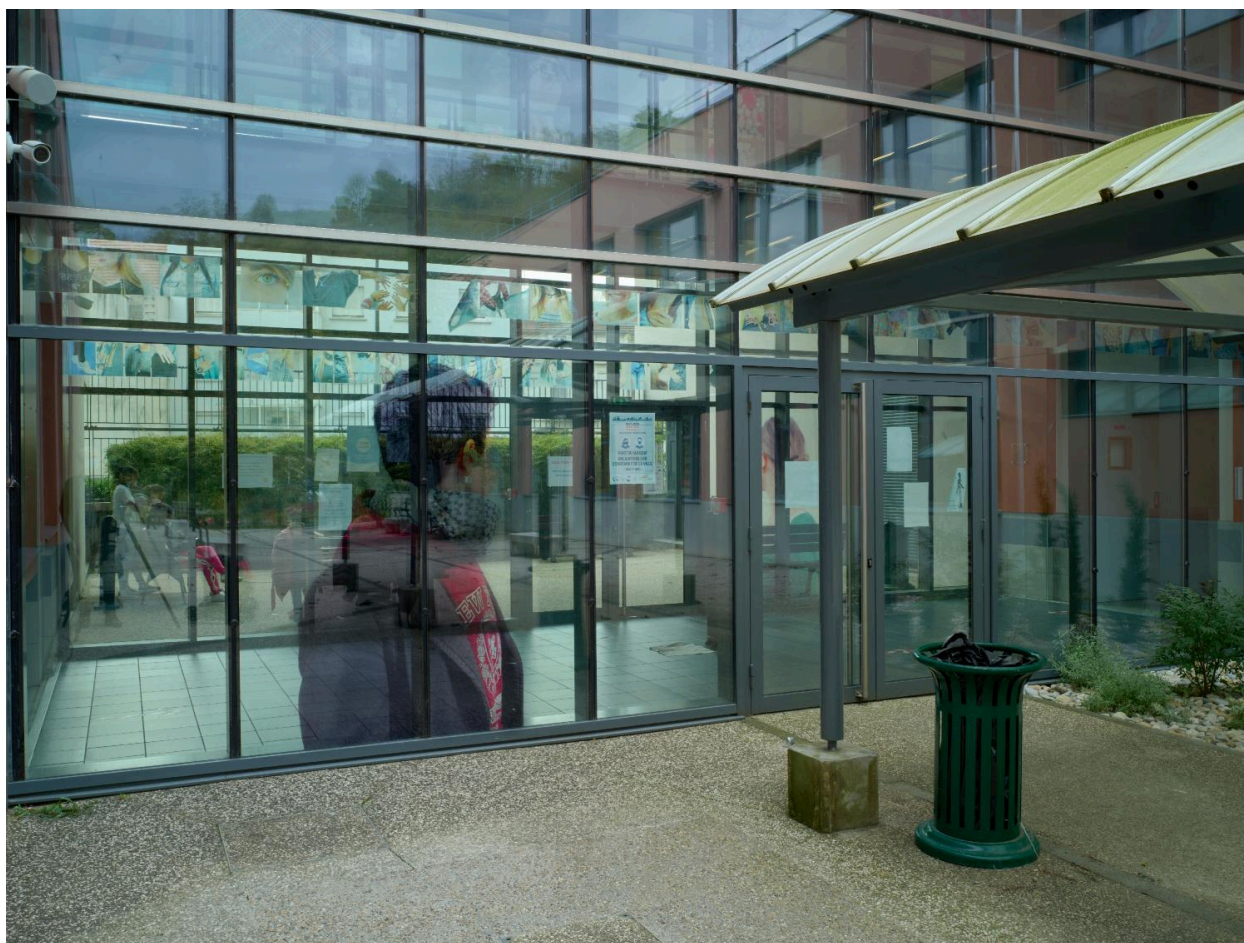
Passerelle : niveau inférieur, vue depuis l'accès extérieur.
