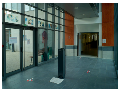
Passerelle : niveau inférieur, vue d'ensemble intérieure. Phot. Christian Parisey IVR84_20204200142NUCA
