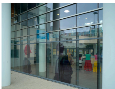
Hall d'accueil : vue depuis l'extérieur. Phot. Christian Parisey IVR84_20204200172NUCA
