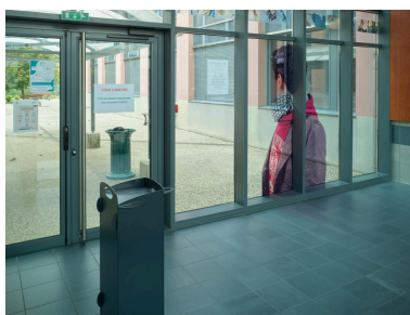
Passerelle : niveau inférieur, paroi latérale. Phot. Christian Parisey IVR84_20204200143NUCA
