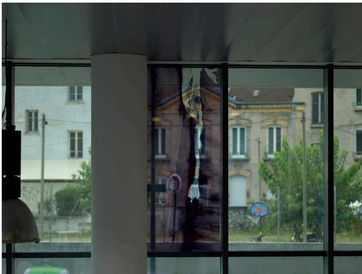
Hall d'entrée : panneau supérieur n° 2.
