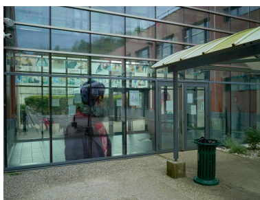
Passerelle : niveau inférieur, vue depuis l'accès extérieur. Phot. Christian Parisey IVR84_20204200145NUCA
