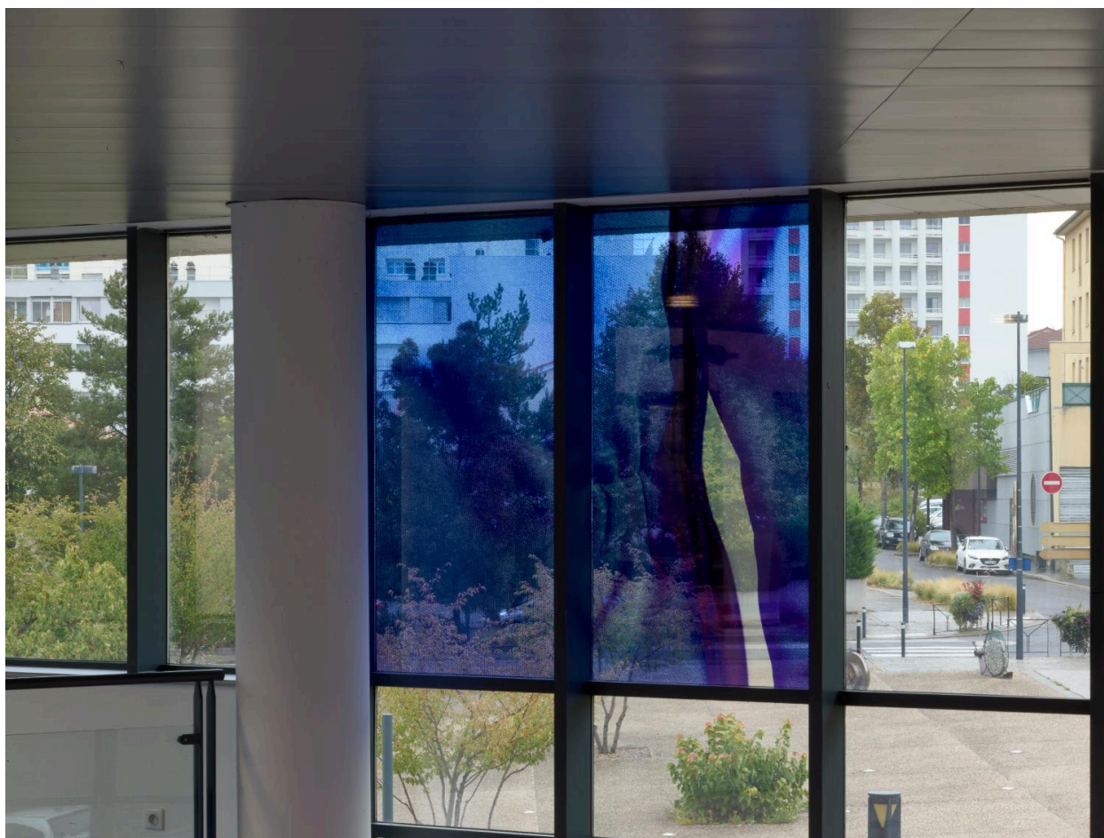
Hall d'entrée : panneau supérieur n° 5.
