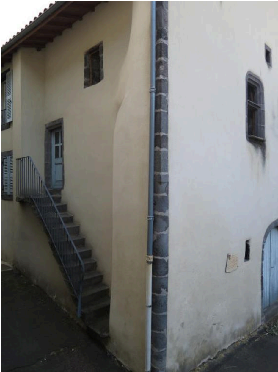
Vue générale des façades principale et latérale
