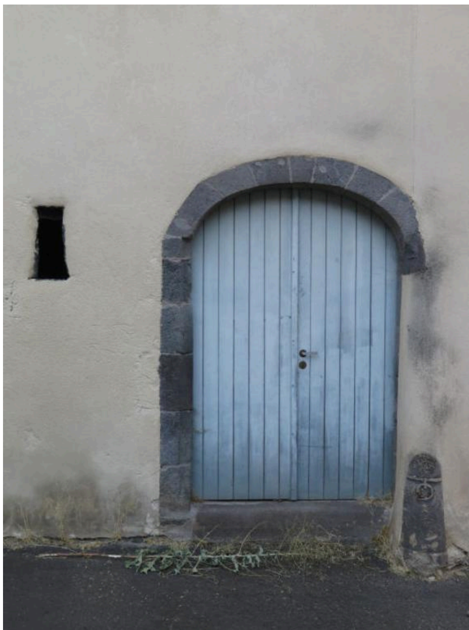
Accès au cuvage et chasse-roue
