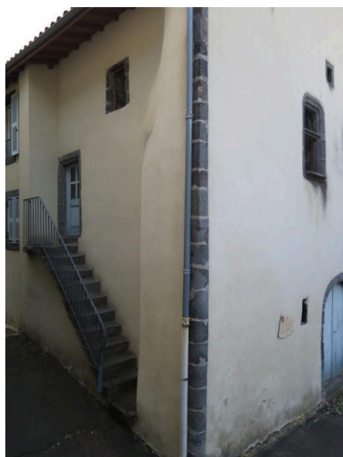
Vue générale des façades principale et latérale Phot. Bruno Decrock IVR84_20206300122NUCA
