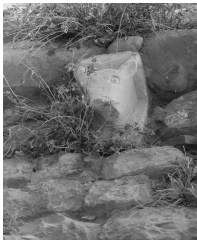
Corbeau ou modillon figuré (en remploi ?), à tête de cochon, dans l'élévation latérale gauche. Phot. Alain Franchella IVR82_19982600272X
