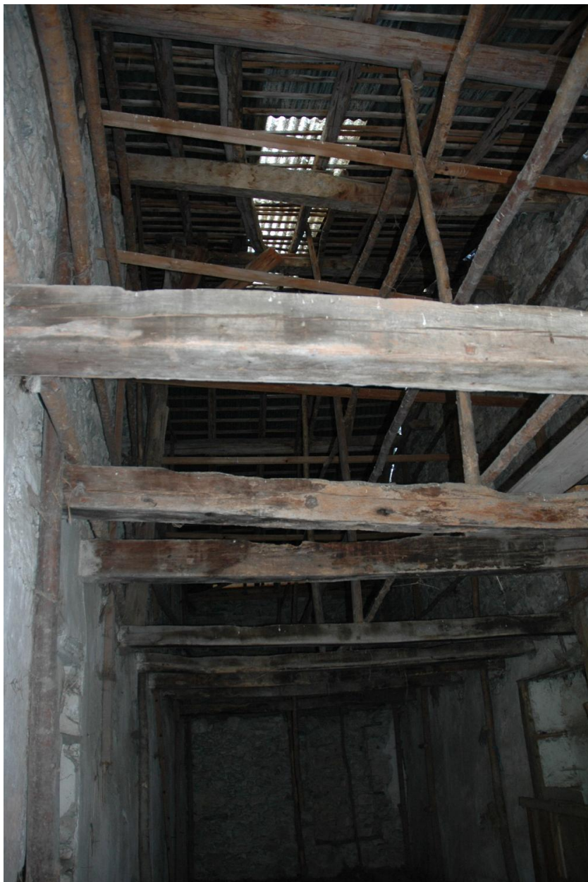
Vue intérieure du comble : perche de séchage.
