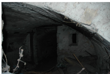
Vue intérieure du cuvage (prise depuis le jour). Phot. Caroline Guibaud IVR84_20247300374NUCA
