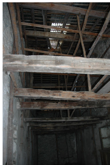
Vue intérieure du comble : perche de séchage. Phot. Caroline Guibaud IVR84_20247300379NUCA
