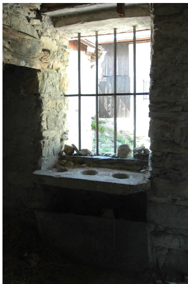
Vue intérieure de la cuisine : potager et cendrier. Phot. Caroline Guibaud IVR84_20247300375NUCA
