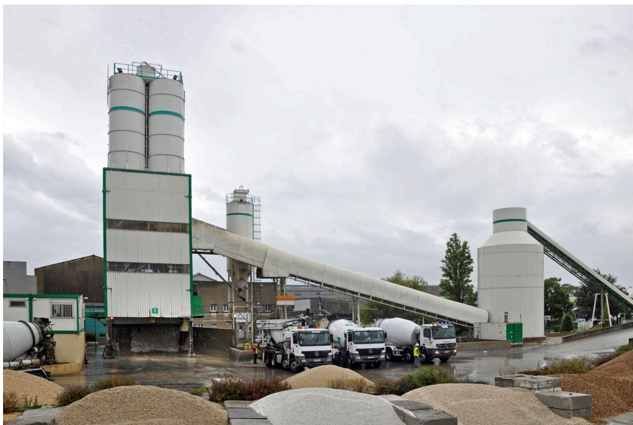
Vue d'ensemble ouest de la cimenterie
