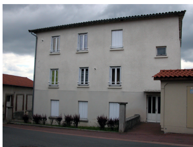
Vue d'ensemble de la maison des soeurs. Phot. Thierry Monnet IVR82_20094200088NUCA
