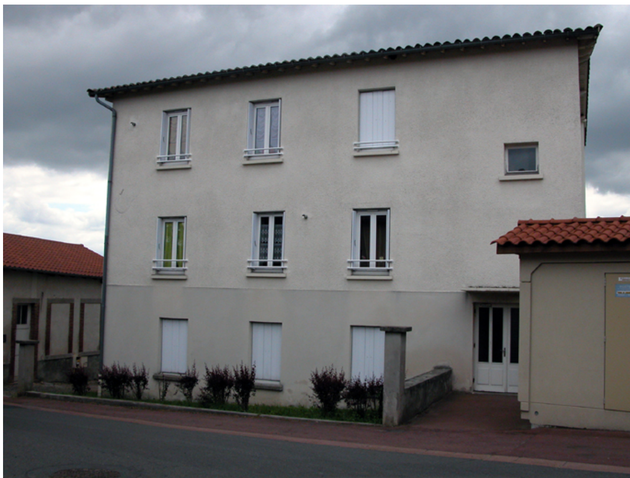
Vue d'ensemble de la maison des soeurs.
