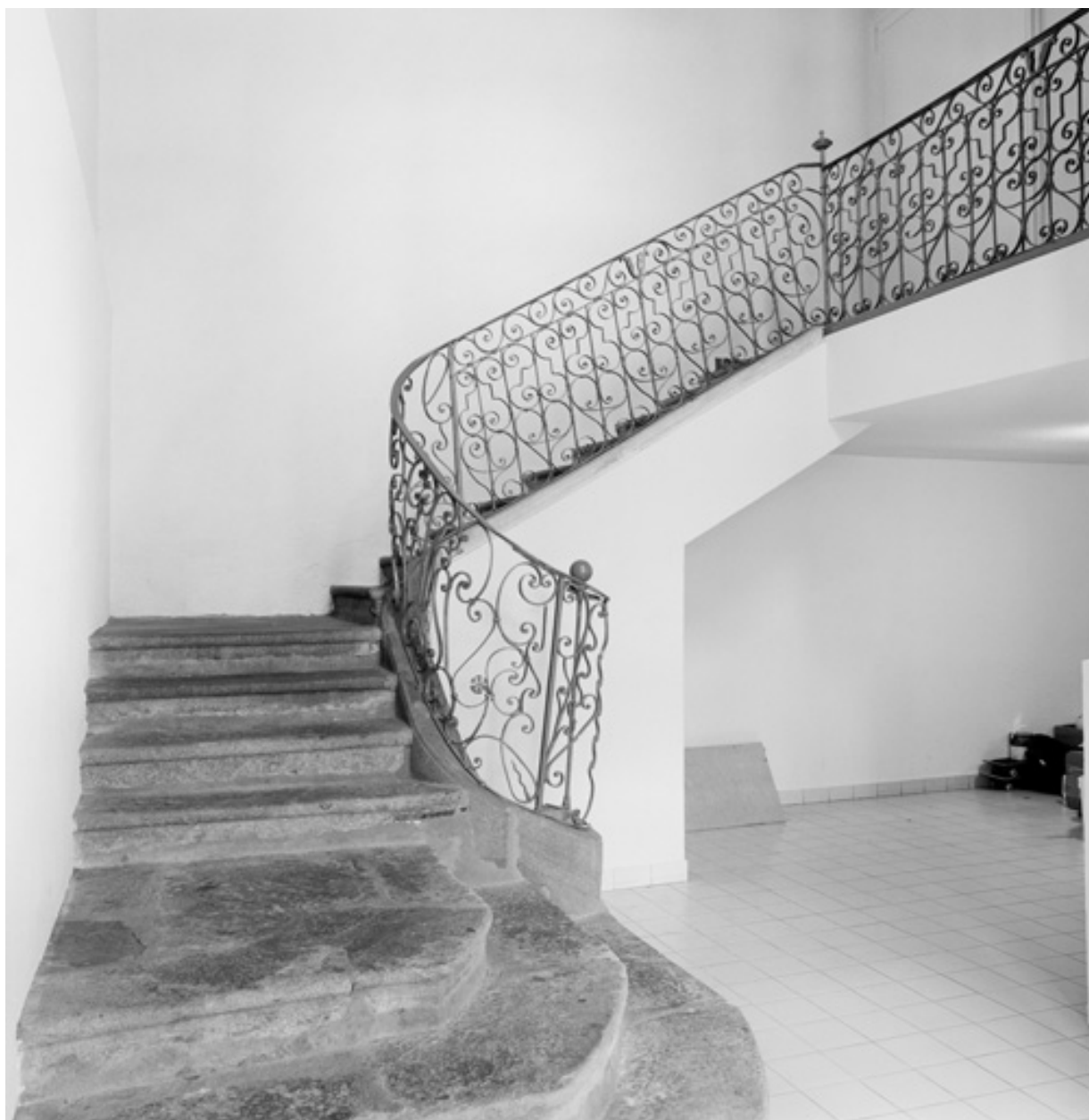
Vue partielle de l'escalier d'honneur.
