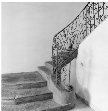
Départ de l'escalier d'honneur : 1ère volée avec garde-corps en ferronnerie du 18e siècle. Phot. Didier Gourbin
