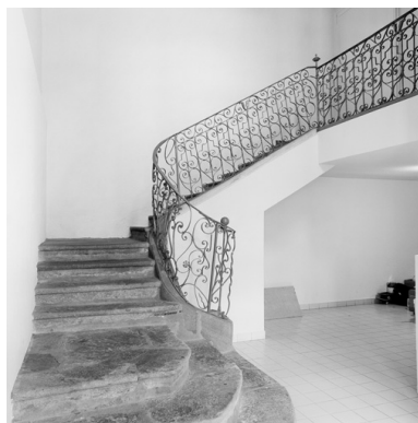
Vue partielle de l'escalier d'honneur. Phot. Didier Gourbin IVR82_20064200948X
