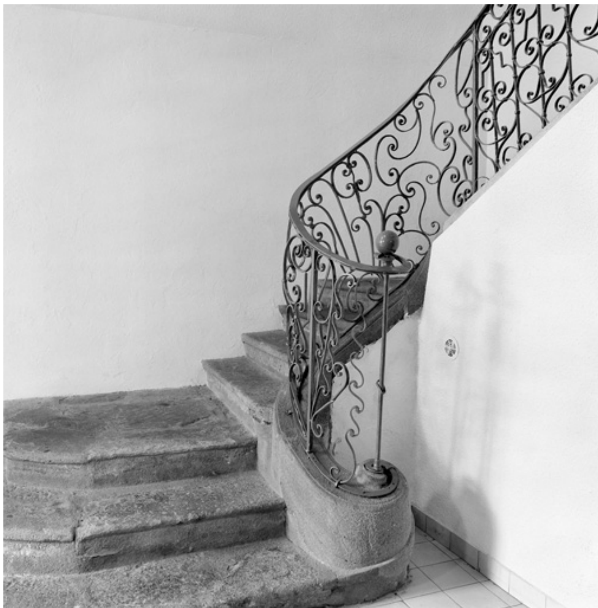
Départ de l'escalier d'honneur : 1ère volée avec garde-corps en ferronnerie du 18e siècle.
