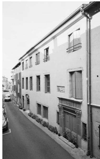
Vue générale de l'élévation sur rue. Phot. Didier Gourbin IVR82_20064200985V
