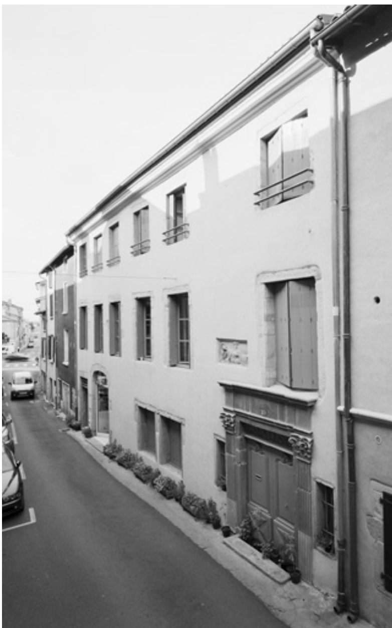
Vue générale de l'élévation sur rue.
