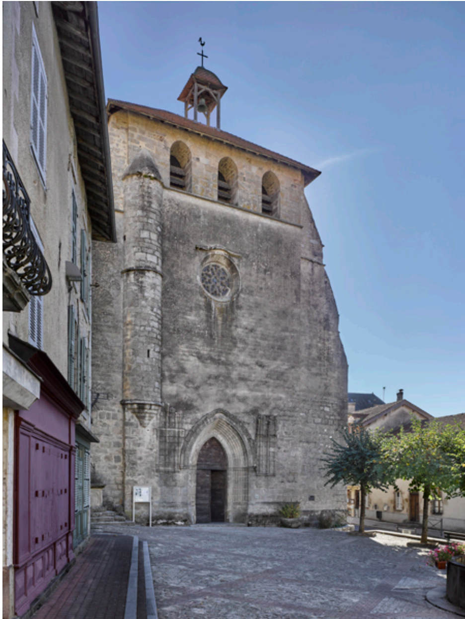
Vue générale de la façade occidentale
