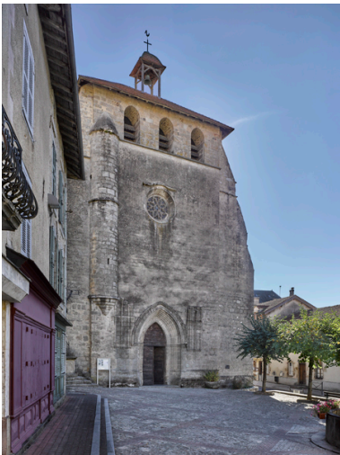
Vue générale de la façade occidentale
