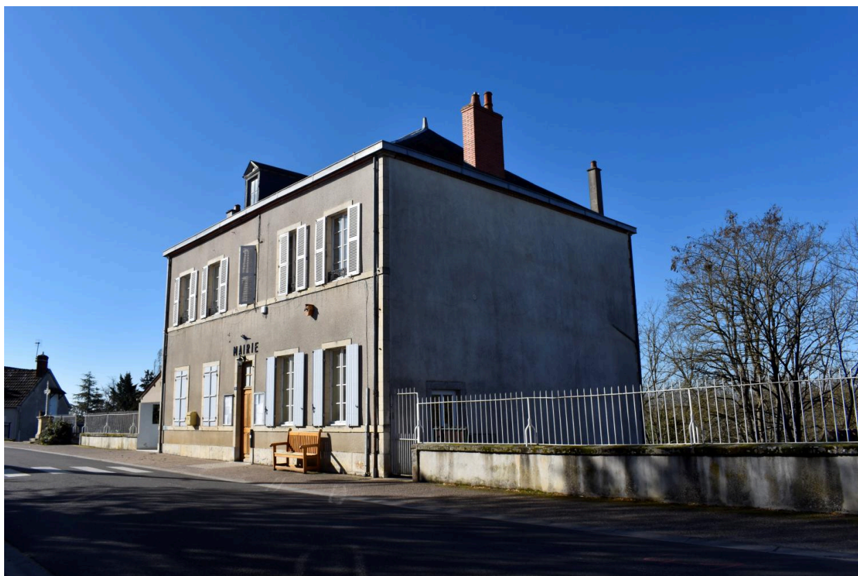
Vue générale de la mairie-école, du nord-est.
