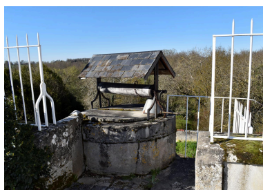
Vue générale du puits de la mairie-école. Phot. Cécile Breton IVR84_20230300513NUC4A
