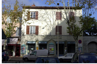
Vue générale, face Phot. Bernard Ducouret IVR82_20026902417NUCA
