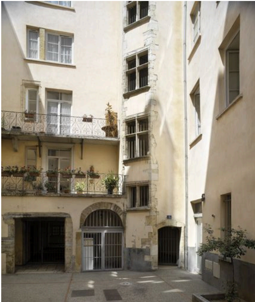
Cour d'entrée I, angle des bâtiments 1 et 2, et tour d'escalier
