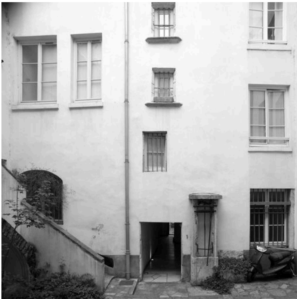
Cour IV, élévation des premiers niveaux du bâtiment 2
