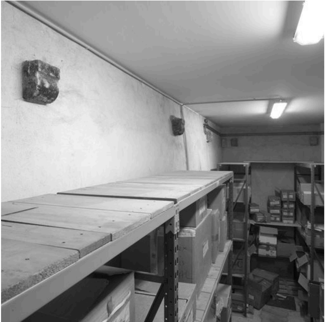
Bâtiment 1, corbeaux qui soutenaient la charpente de la galerie ouest du cloître
