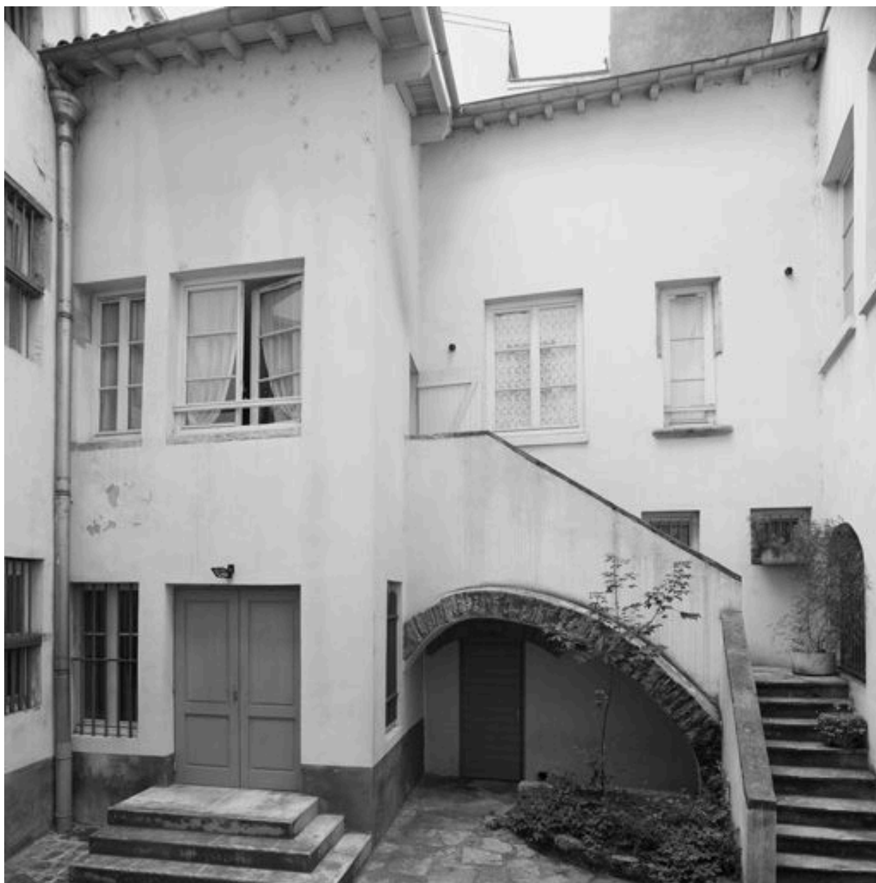
Cour IV, élévation du bâtiment 3 et escalier extérieur
