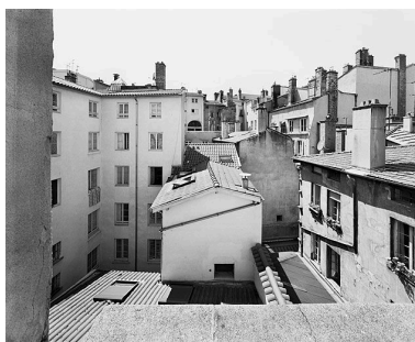
Bâtiments bordant la cour IV, vue prise depuis le temple des Terreaux : bâtiment 2 à gauche, pignon du bâtiment 5 au centre Phot. Eric Dessert IVR82_20046900557V
