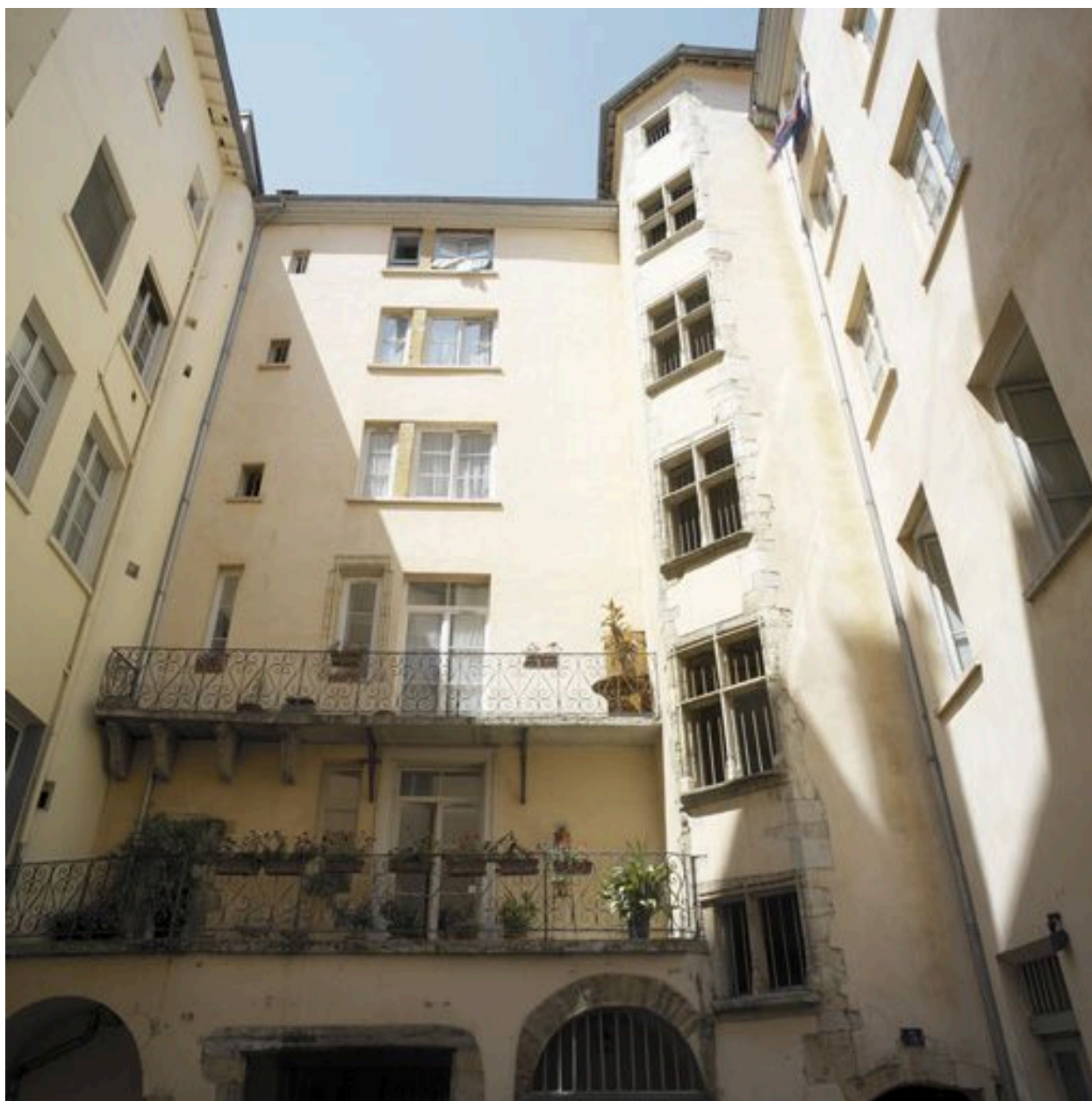
Cour d'entrée I, vue générale du bâtiment 2 et de la tour d'escalier
