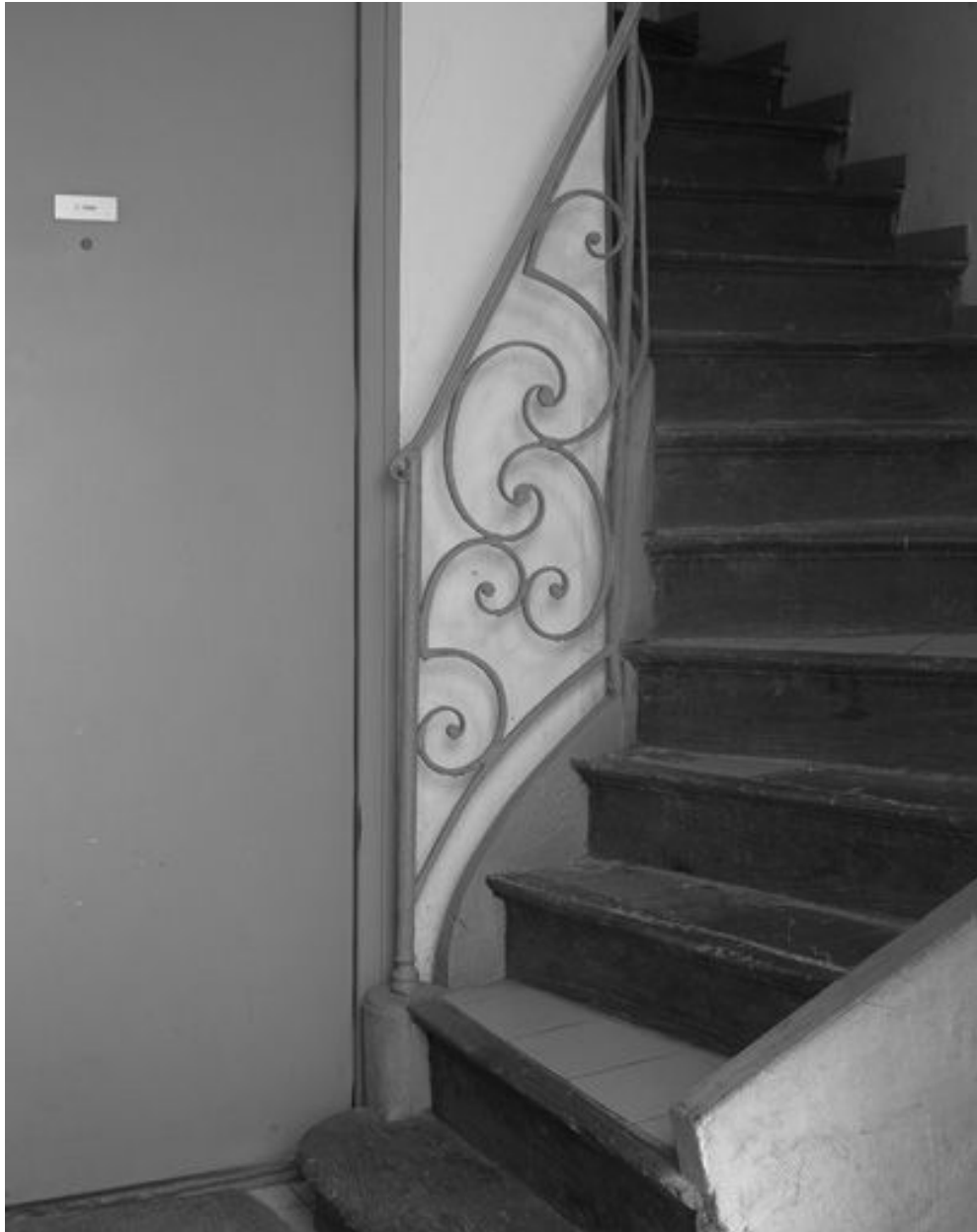
Bâtiment 5, escalier, palier du rez-de-chaussée
