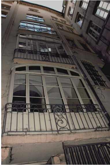
Vue de l'élévation sur cour Phot. Catherine Guégan IVR82_20066900769NUCA
