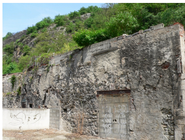
Mur à l'arrière Phot. Isabelle Dupuis IVR82_20093800474NUCA
