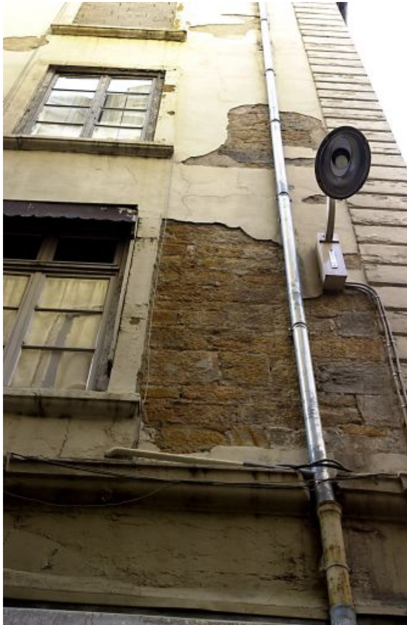
Façade rue Longue, détail de l'appareillage des moellons au 2e niveau
