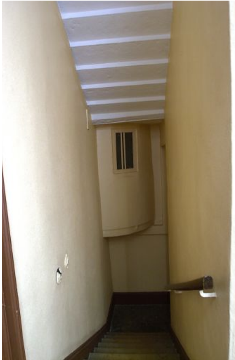
Escalier, vue du premier étage vers le repos inférieur
