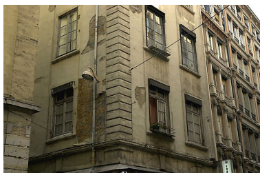
Détail de l'angle des deux façades Phot. Lore Derail IVR82_20046900033NUCA
