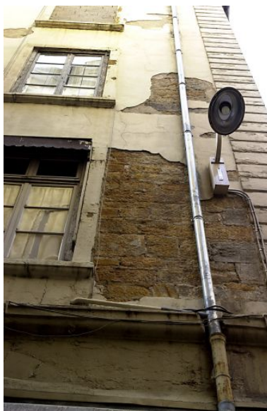
Façade rue Longue, détail de l'appareillage des moellons au 2 e niveau Phot. Lore Derail IVR82_20046900034NUCA
