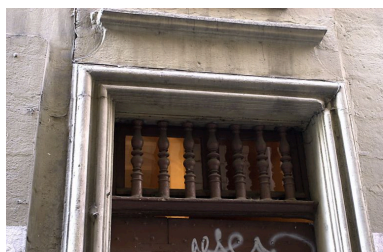
Façade rue Longue, porte, détail du tympan de menuiserie Phot. Lore Derail IVR82_20046900036NUCA
