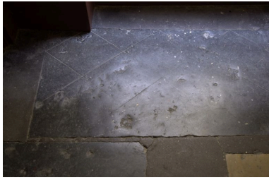
Escalier, palier du second étage, détail de la dalle gravée en faux pavage Phot. Bernard Ducouret IVR82_20046900038NUCA
