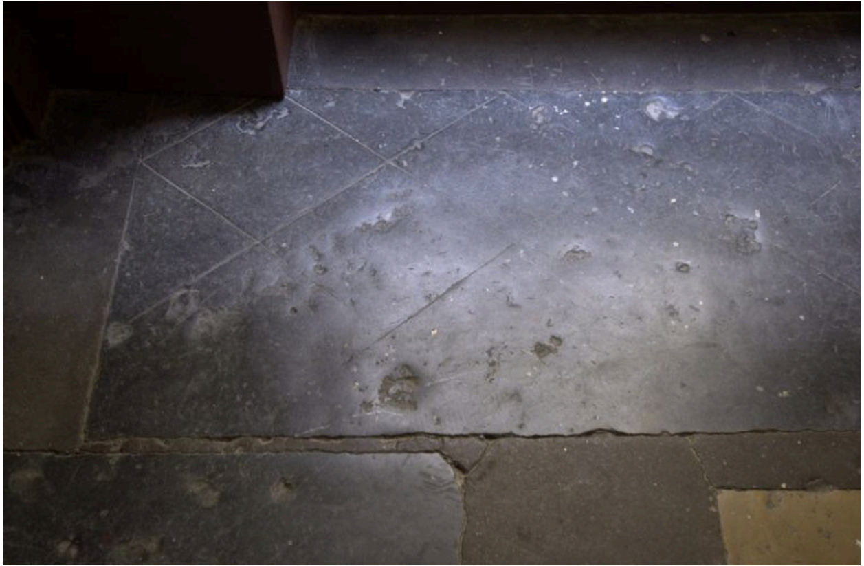
Escalier, palier du second étage, détail de la dalle gravée en faux pavage
