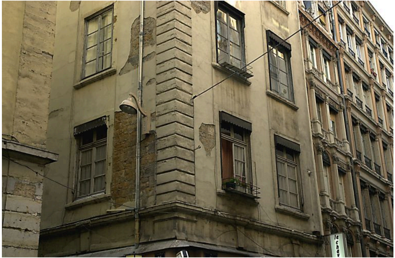
Détail de l'angle des deux façades
