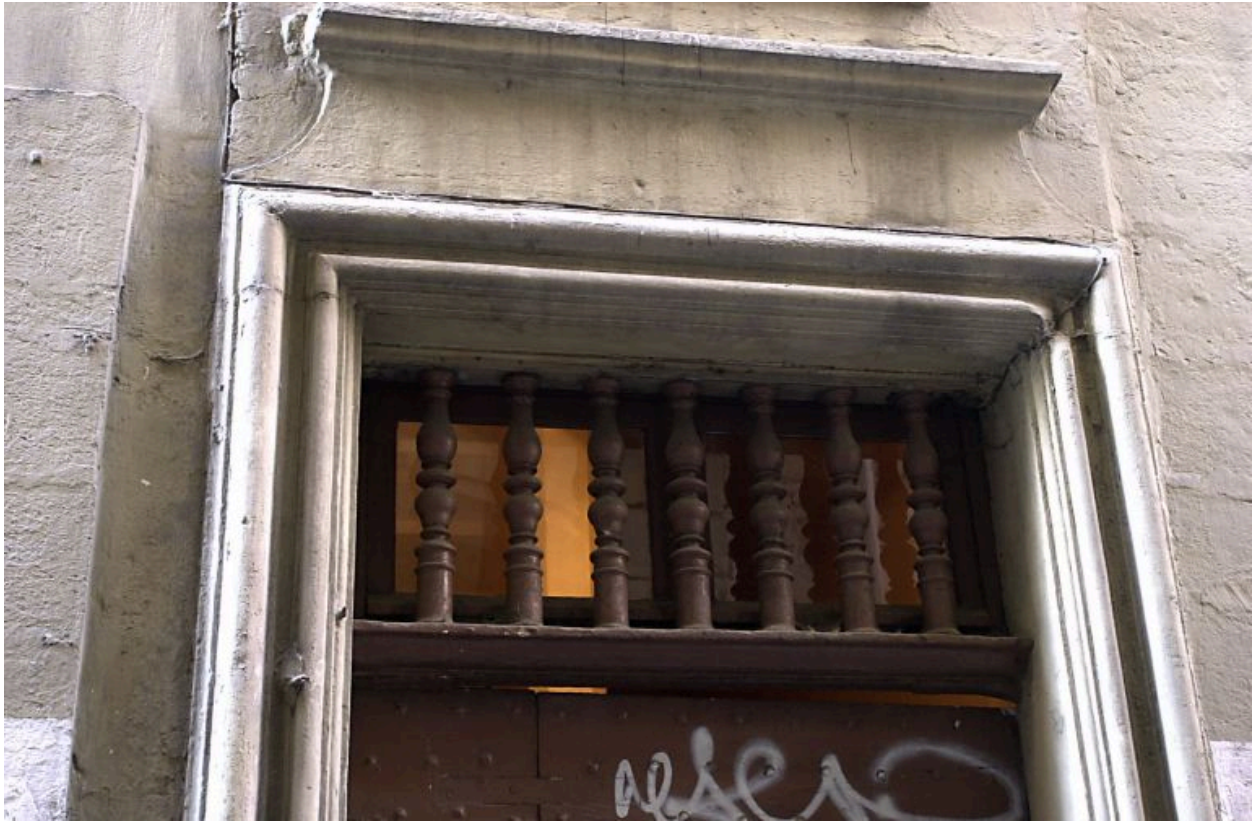
Façade rue Longue, porte, détail du tympan de menuiserie
