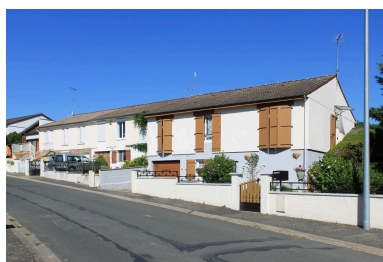
Domérat, lotissement de Bressolles, maisons de type Rubis 5 sur sous-sol avec entrée de garage en façade principale, n° 52, 54 et 56 boulevard du président Allende. Phot. Christophe Laurent IVR84_20210300108NUCA
