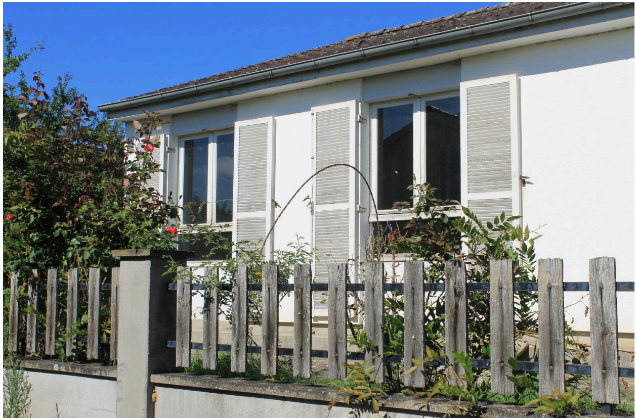
Domérat, lotissement de Bressolles, maison de type Rubis 5 sur vide-sanitaire, n° 11 impasse Eugène-Delacroix, détail des huisseries d'origine.
