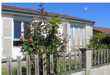
Domérat, lotissement de Bressolles, maison de type Rubis 5 sur vide-sanitaire, n° 11 impasse Eugène-Delacroix, détail des huisseries d'origine. Phot. Christophe Laurent IVR84_20210300106NUCA
