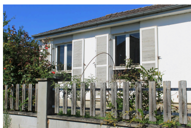
Domérat, lotissement de Bressolles, maison de type Rubis 5 sur vide-sanitaire, n° 11 impasse Eugène-Delacroix, détail des huisseries d'origine. Phot. Christophe Laurent IVR84_20210300105NUCA
