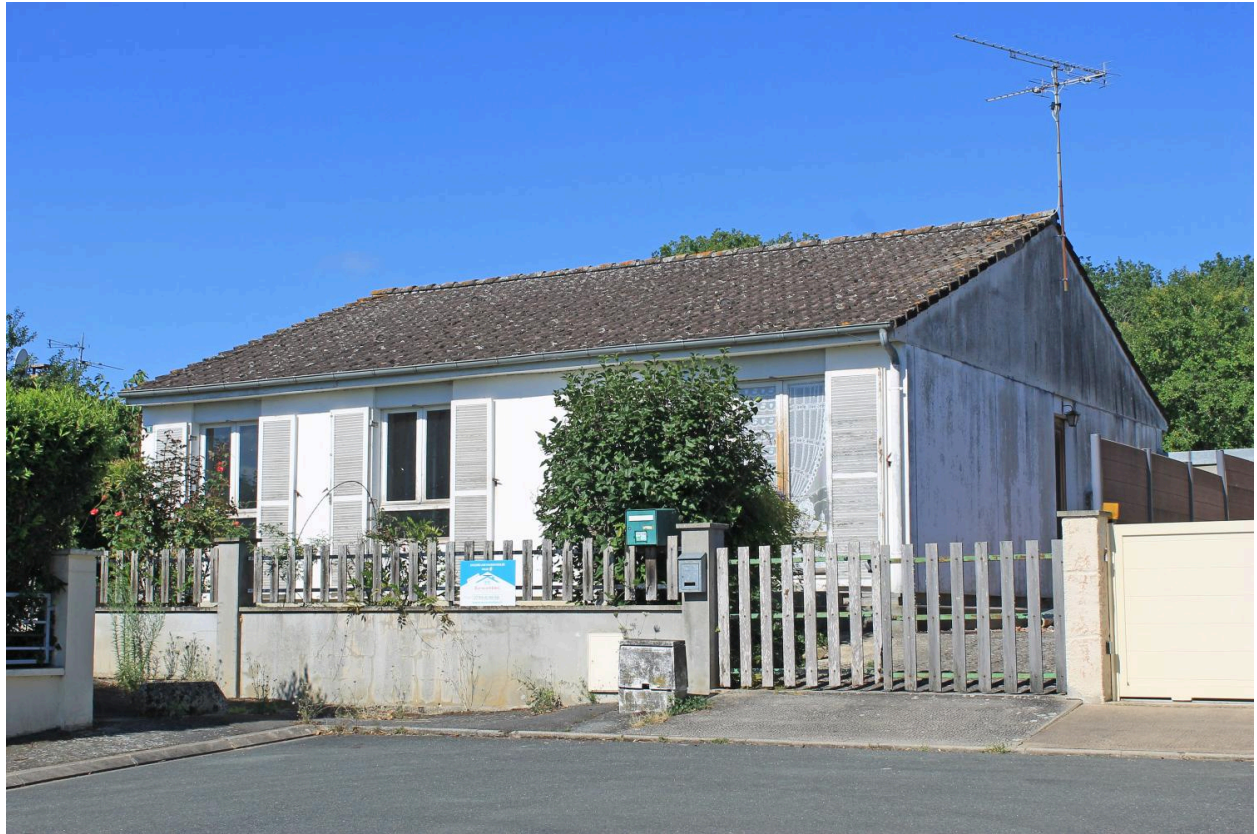
Domérat, lotissement de Bressolles, maison de type Rubis 5 sur vide-sanitaire, n° 11 impasse Eugène-Delacroix (rare exemple de maison encore très proche de son état d'origine).
