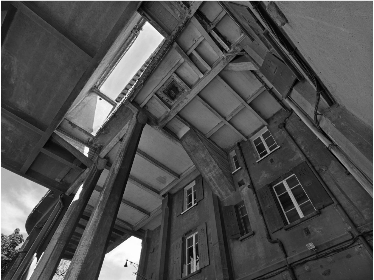
Bureau sur pilotis au dernier niveau.
