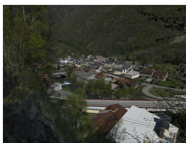
Vue d'ensemble des usines Keller et Leleux à Livet. Phot. Thierry Leroy IVR82_20143801221NUCAQ
