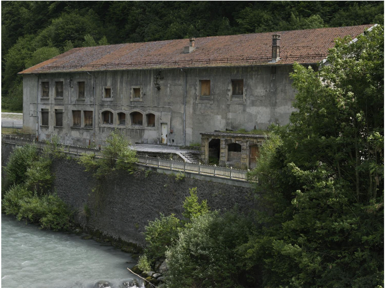
Façade côté Romanche.
