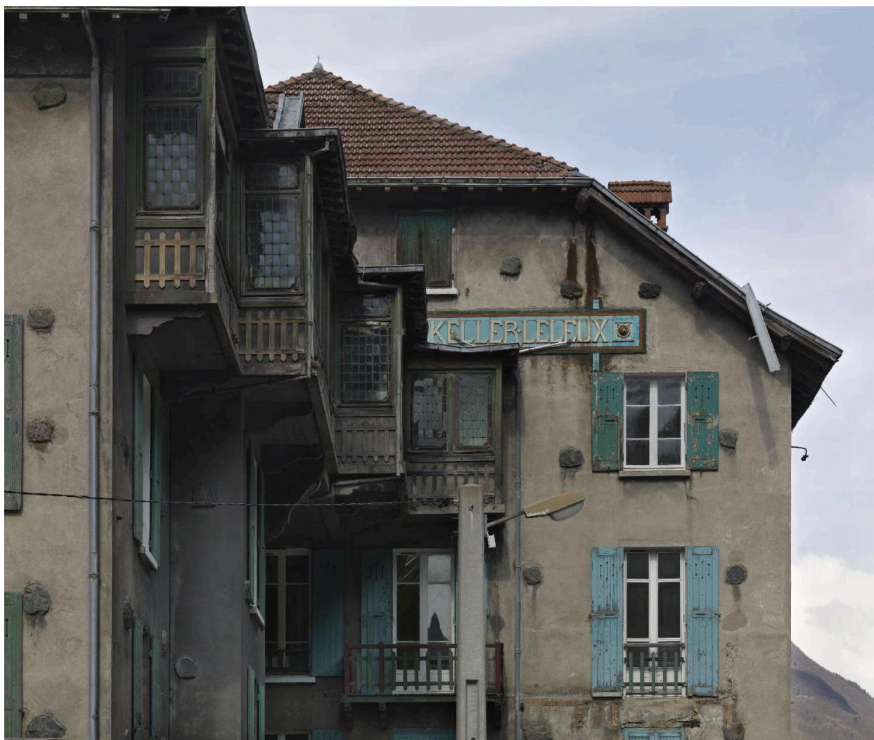
Galleries fermées du dernier étage en façade principale.
