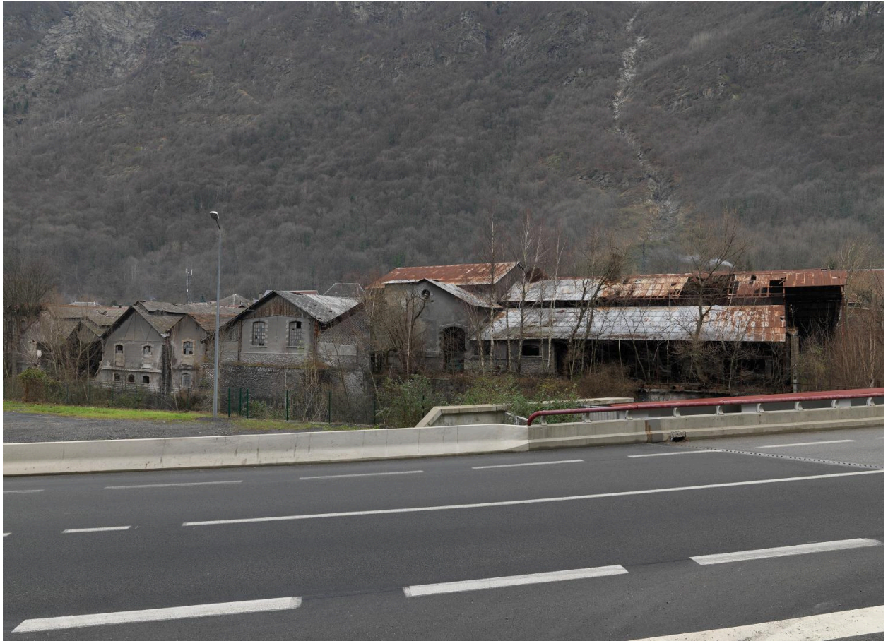
Vue des ateliers des usines Keller restant aujourd'hui à Livet
