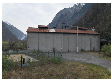
Vue d'un atelier des anciennes usines Keller Phot. Thierry Leroy IVR82_20143801762NUCAQ
