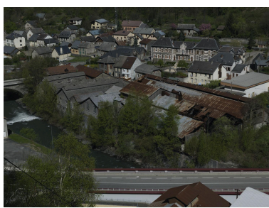
Vue des usines Keller et Leleux à Livet. Phot. Thierry Leroy IVR82_20143801222NUCA
