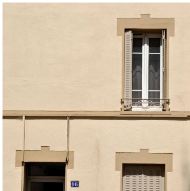
Elévation sur rue, vue rapprochée montrant les effets de décor dans l'enduit Phot. Magali Delavenne IVR84_20176901057NUCA
