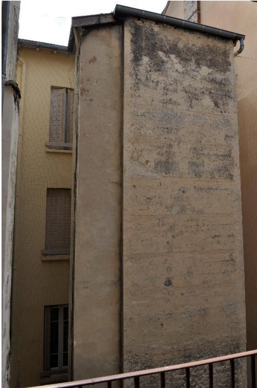
Elévation sur cour, vue partielle montrant les matériaux de la tour d'escalier, sur l'arrière
