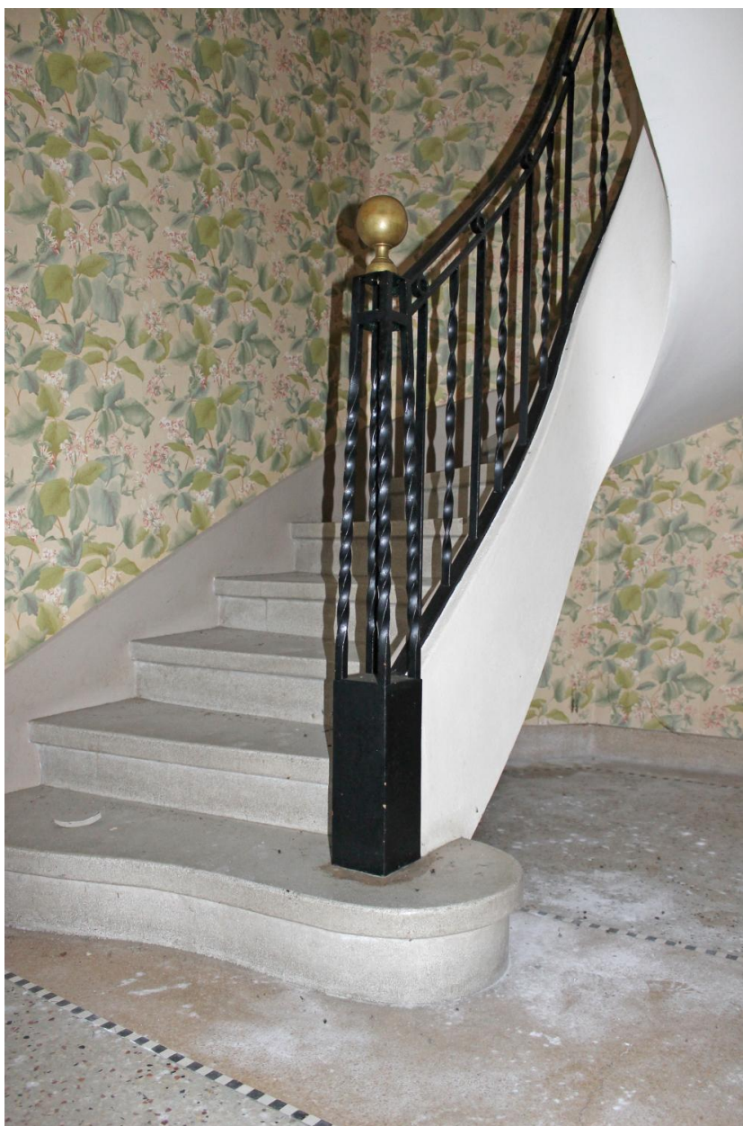
Pérignat-lès-Sarliève, la maison B.*, le départ de l'escalier principal au rez-de-chaussée avec sa première marche en volute et ondulée, ses marches suivantes gironnées, ainsi que le départ de sa rampe d'appui en ferronnerie.
