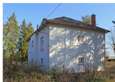
Pérignat-lès-Sarliève, la maison B.*, les façades sud et ouest. Phot. Christophe Laurent IVR84_20216302531NUCA
