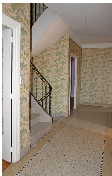
Pérignat-lès-Sarliève, la maison B.*, le couloir longitudinal du premier étage et son sol en granito et mosaïque. Phot. Christophe Laurent IVR84_20216302535NUCA
