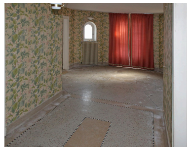
Pérignat-lès-Sarliève, la maison B.*, le vestibule du rez-de-chaussée et son sol en granito et mosaïque. Phot. Christophe Laurent IVR84_20216302534NUCA
