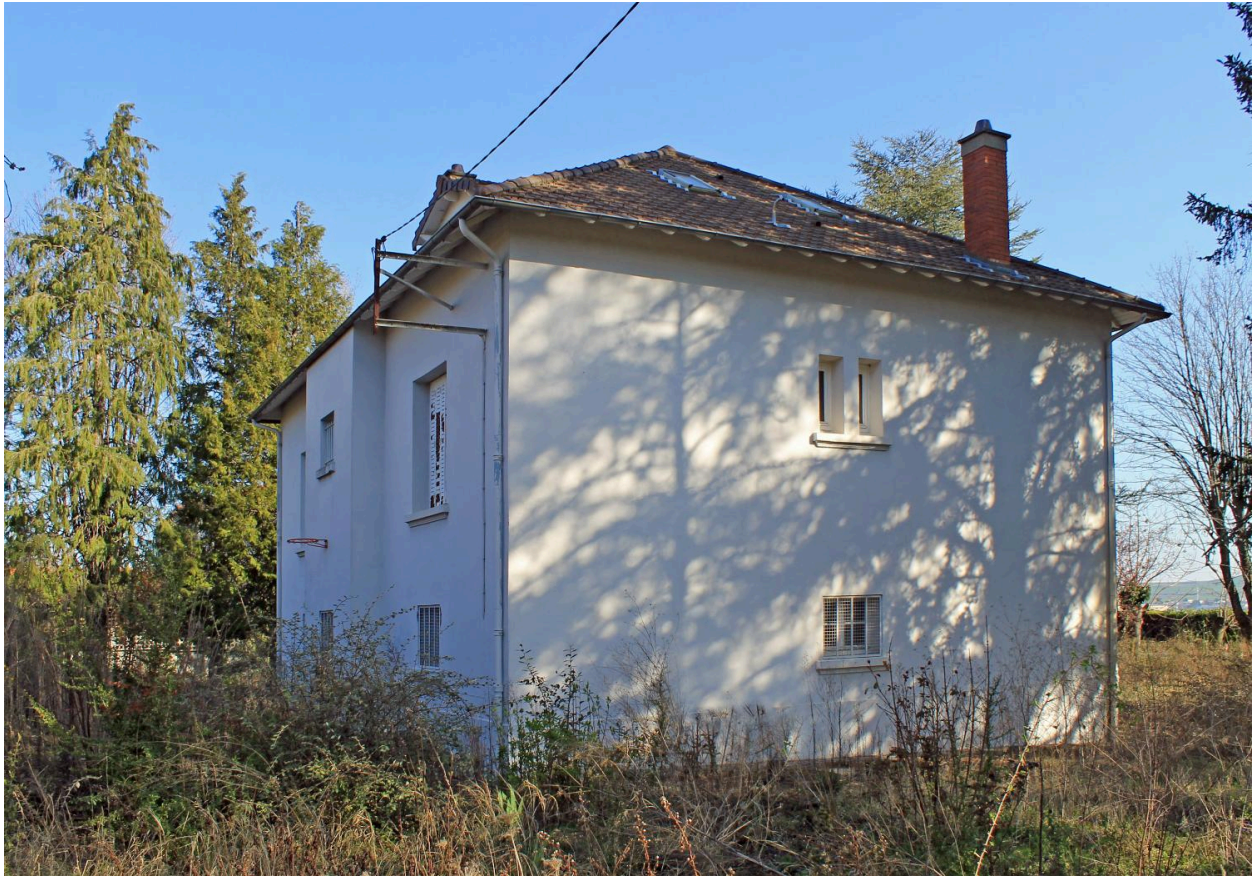
Pérignat-lès-Sarliève, la maison B.*, les façades sud et ouest.
