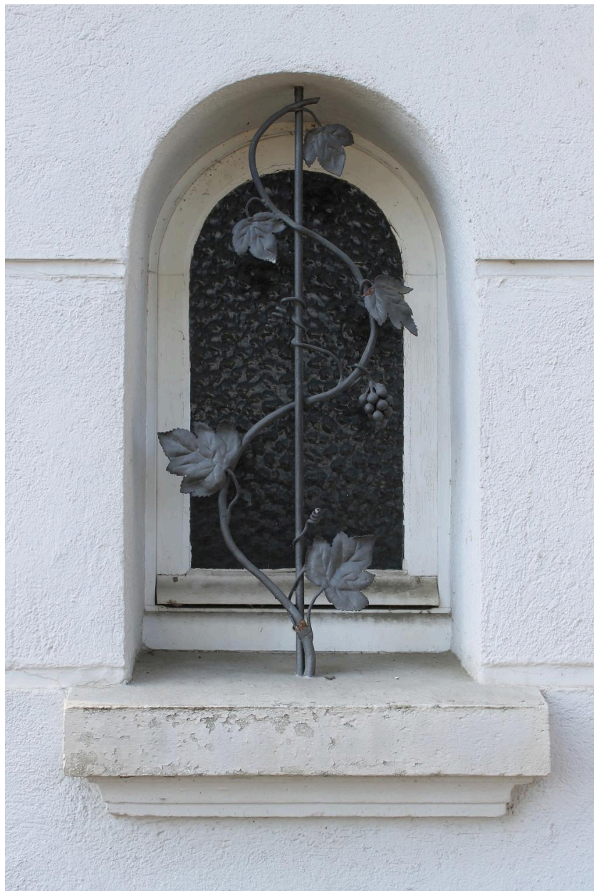
Pérignat-lès-Sarliève, la maison B.*, détail d'une ferronnerie ornant au rez-de-chaussée l'une des fenêtres de l'avant-corps.
