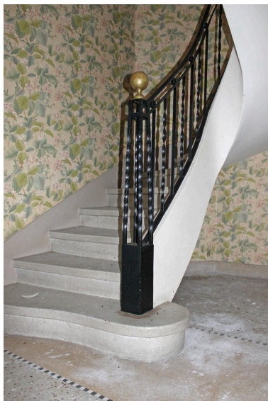
Pérignat-lès-Sarliève, la maison B.*, le départ de l'escalier principal au rez-de-chaussée avec sa première marche en volute et ondulée, ses marches suivantes gironnées, ainsi que le départ de sa rampe d'appui en ferronnerie. Phot. Christophe Laurent IVR84_20216302533NUCA
