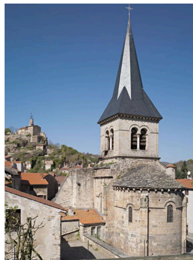
Vue de l'angle sud-est Phot. Jean-Michel Périn IVR83_20146300252NUC4A
