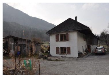
Vue du moulin transformé en logement. Phot. Clara Bérelle IVR82_20137301645NUCA
