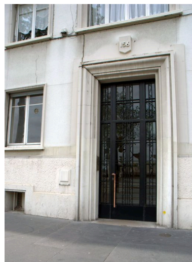
Porte d'entrée sur le cours Gambetta Phot. Maryannick Chalabi IVR82_20116901521NUCA
