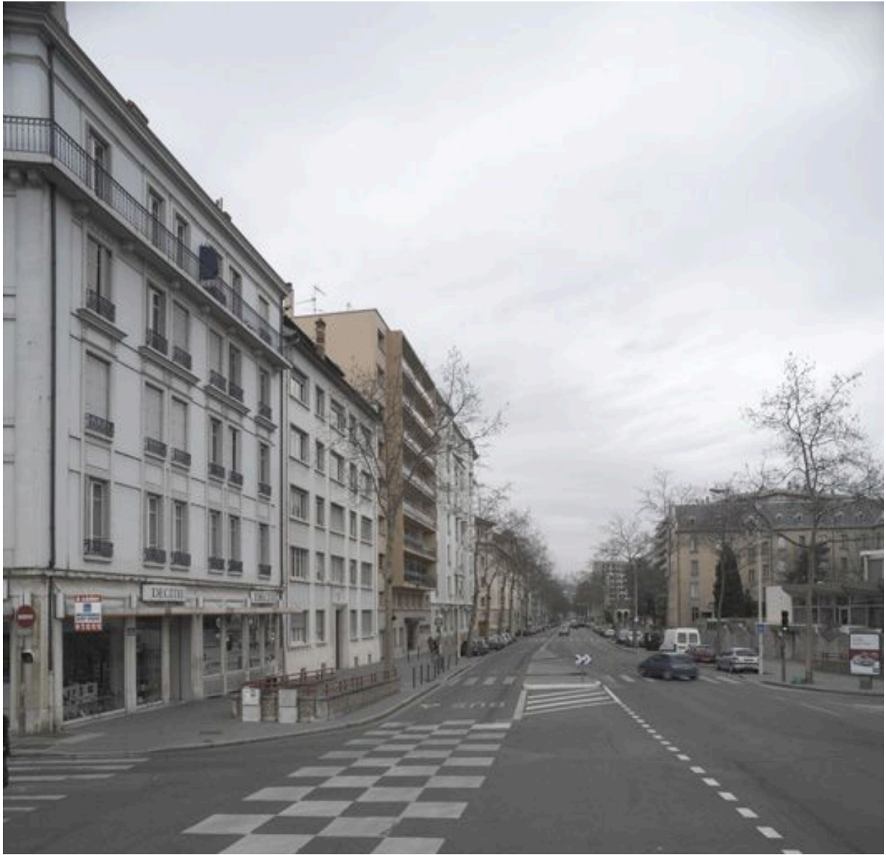
Elévation principale depuis l'est
