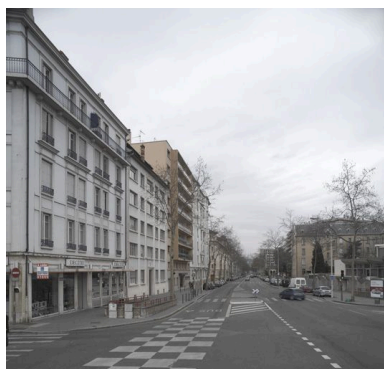
Elévation principale depuis l'est Phot. Eric Dessert IVR82_20056900624NUCA
